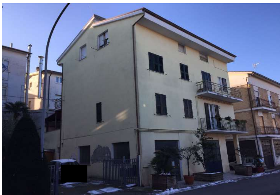
Foto del 14/2/21 fronte nord-est nord/ovest via A.Manzoni
