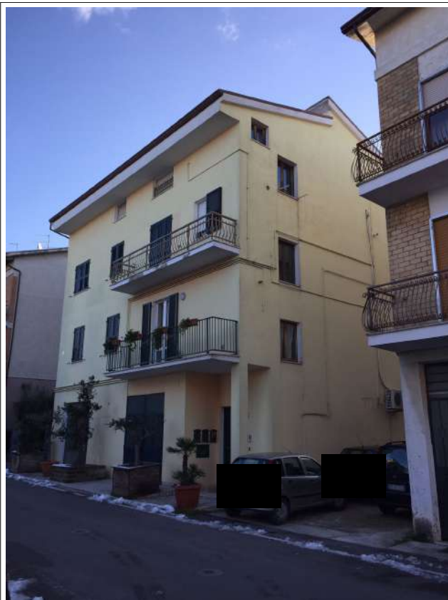
Foto 14/2/21 fronte nord /ovest via Manzoni
