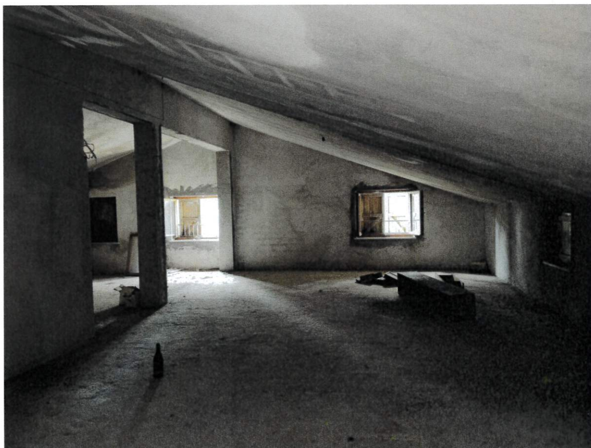
Soffitte al P.1°
