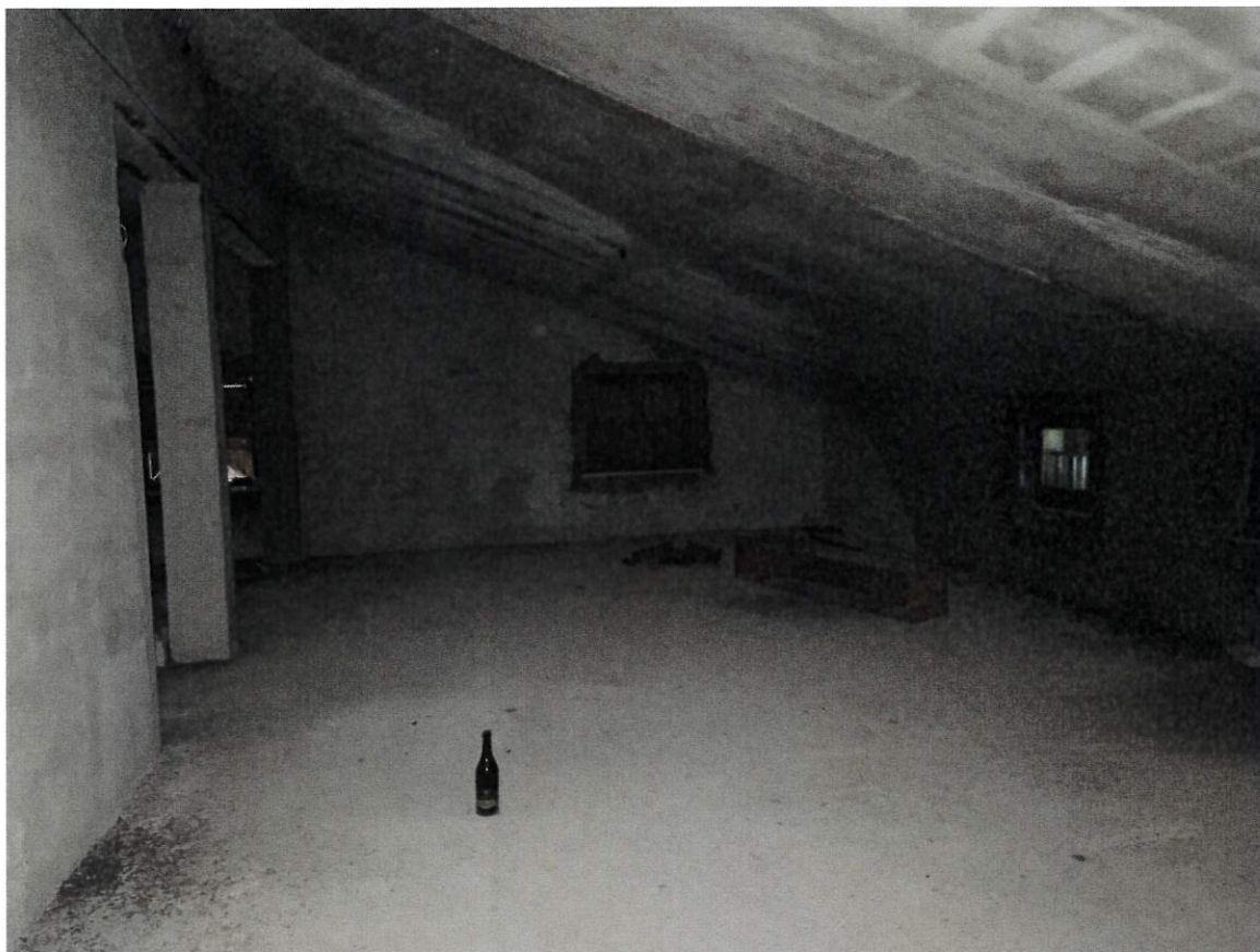
Soffitte al P.1°
