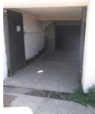
Rampa di ingresso al locale
