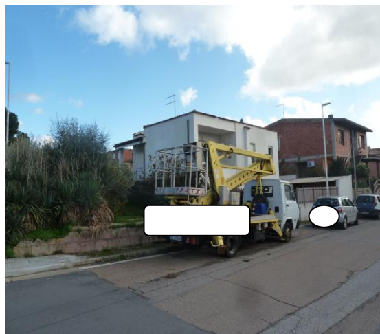
Foto n. 3 Prospetto via Camposanto
