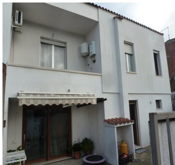
Foto n. 5 prospetto su via Camposanto
