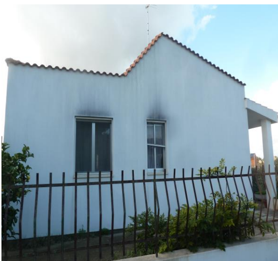
Foto n. 6 prospetto via Michelangelo
