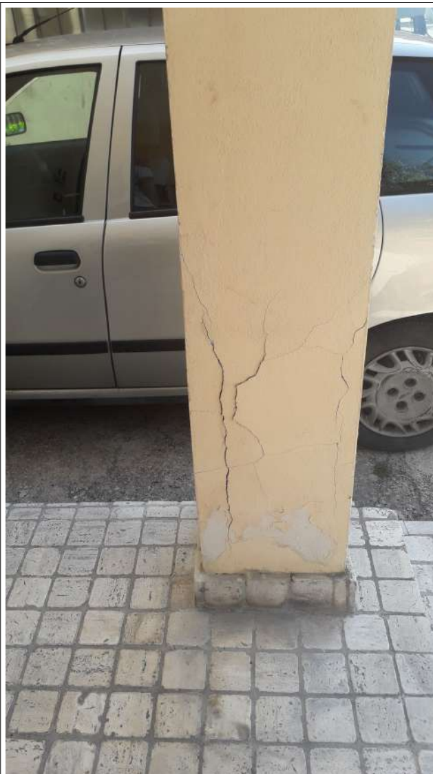
Particolare pilastro loggia ingresso
