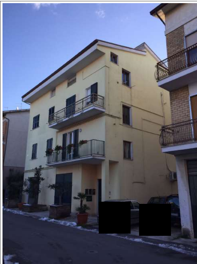
Foto 14/2/21 fronte nord /ovest via Manzoni
