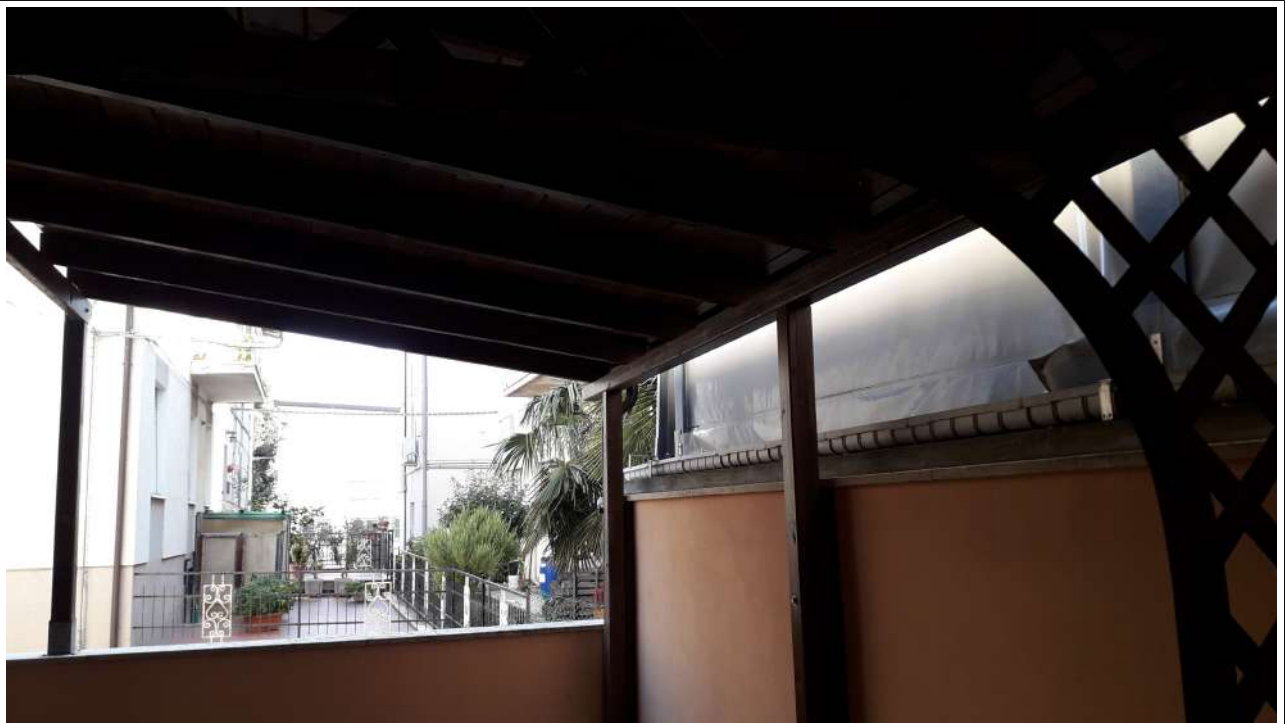
Particolare terrazzo coperto
