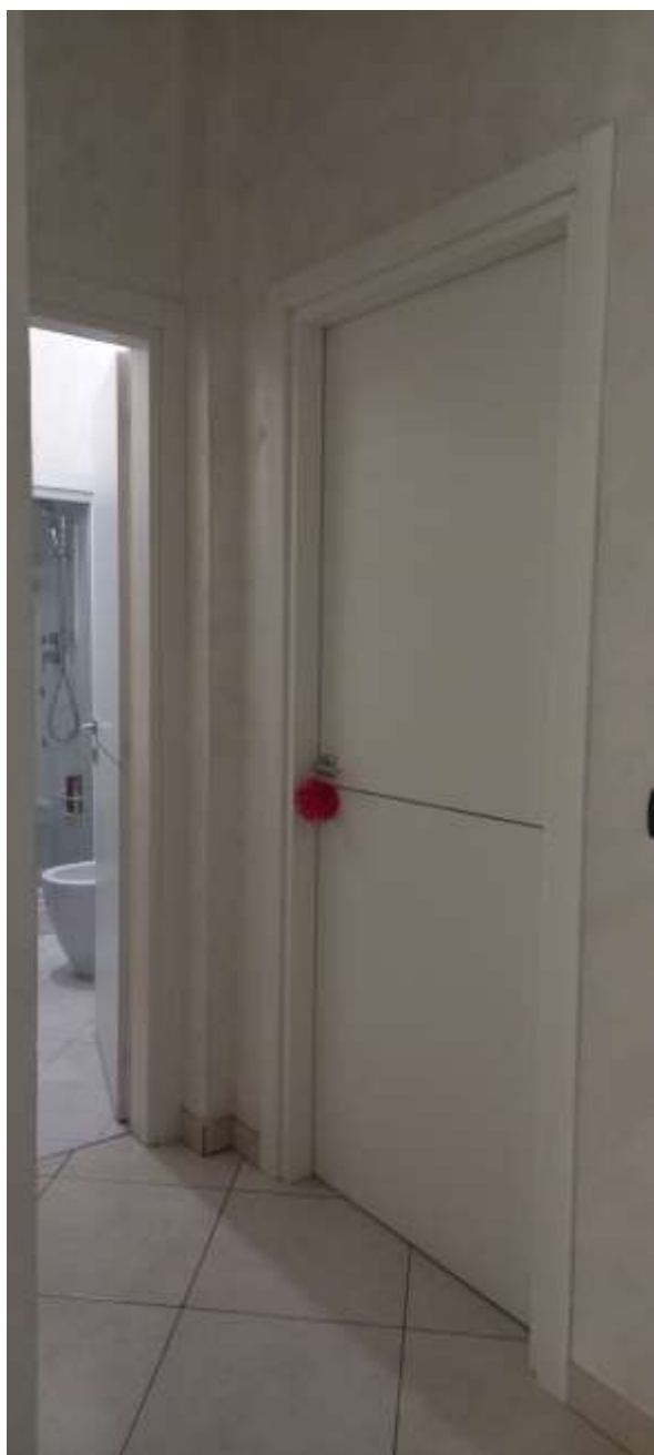
Foto 10 – Immobile “1A” – Accesso (tamponato) all’unità immobiliare 2
