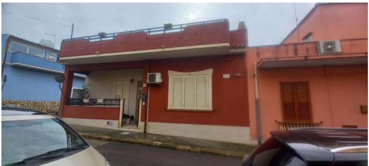
Foto 1 – Immoblie “1A” – Prospetto di via De Sanctis
