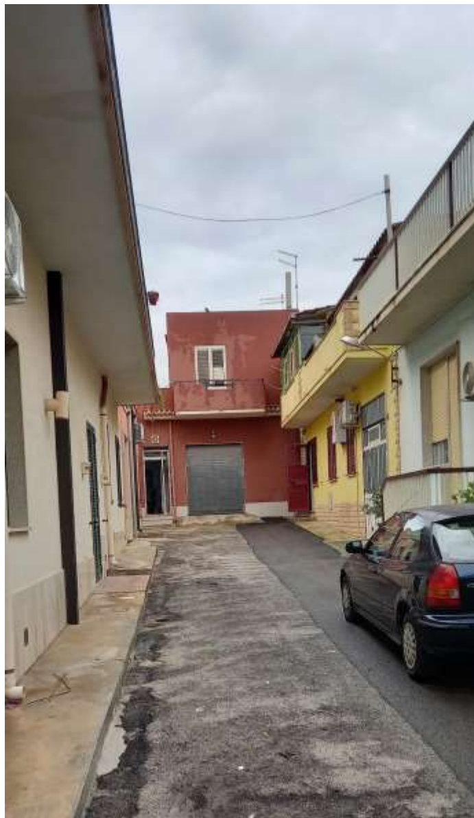
Foto 4 – Immobile "1A" – Prospetto di via delle Ortensie
