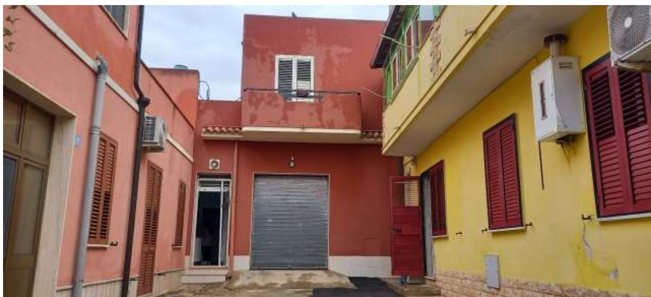
Foto 5 – Immobile “1A” – Prospetto di via delle Ortensie
