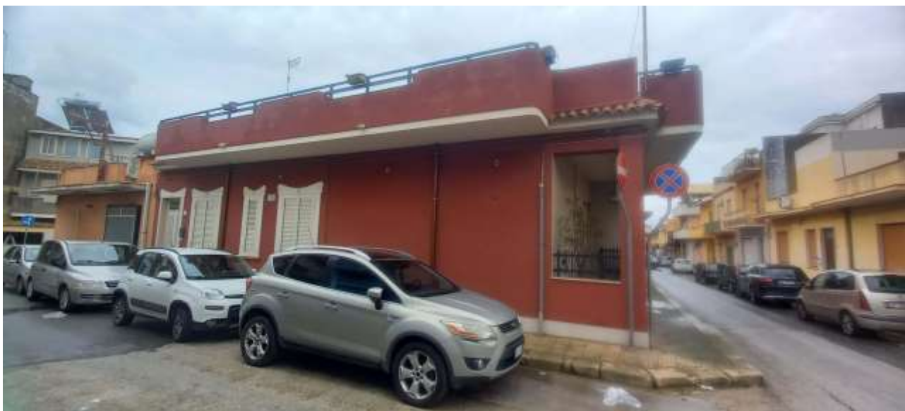
Foto 2 – Immobilità "1A" – Prospetto di via dei Tulipani
