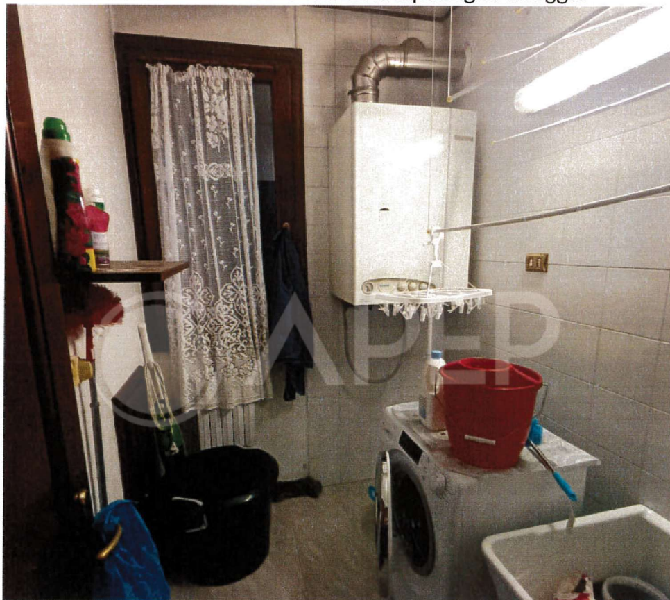
Foto n. 14 – Vista lavanderia ripostiglio alloggio
