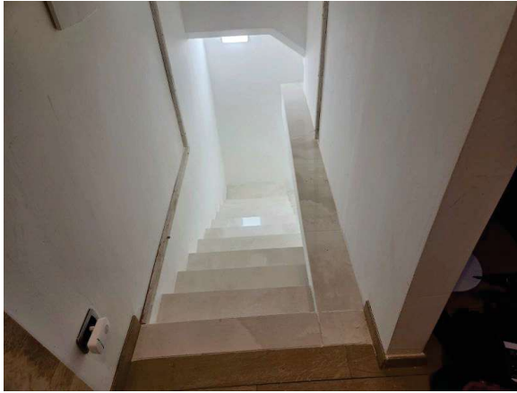
Scala di accesso al piano interrato
