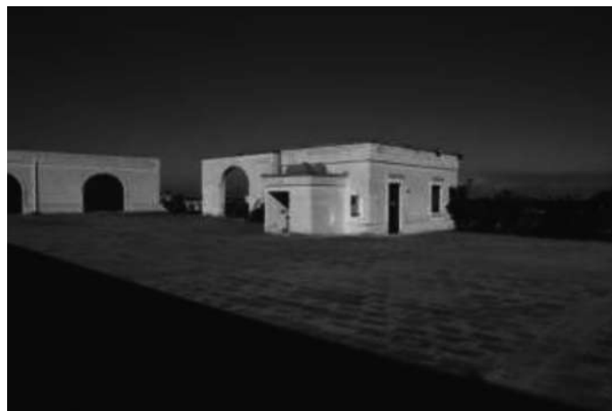
Foto 5 Ufficio sub34 e piazzale sub 38
