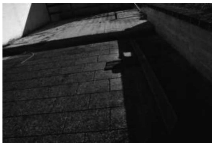
Foto 121 Botola cisterna sulla sub38 e area pavimentata
