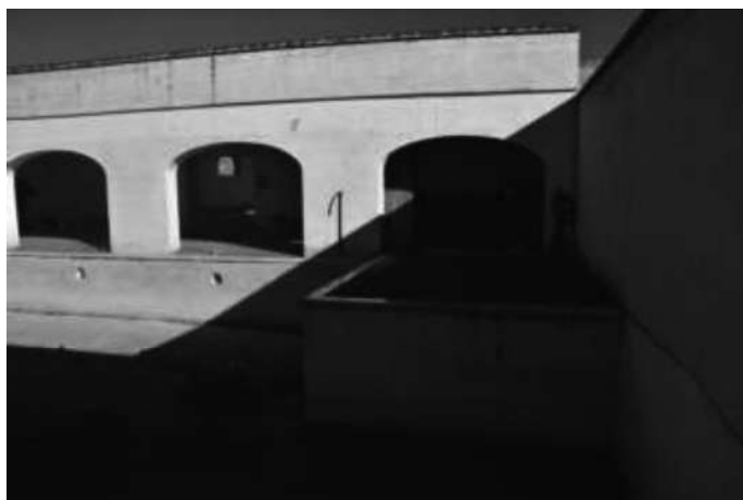
Foto 100 Sub 42 – Piscina scoperta
