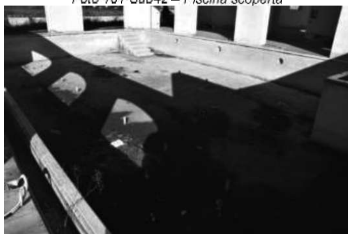
Foto 103 Sub 42 – Piscina scoperta
