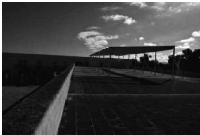
Foto 133 Vista del solaio
