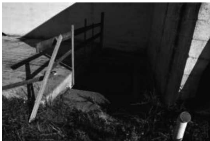
Foto 118 Botola cisterna sulla sub38
