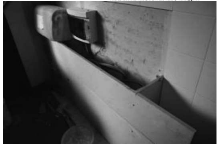
Foto 95 Interno sub 40 – cucine ristorante
