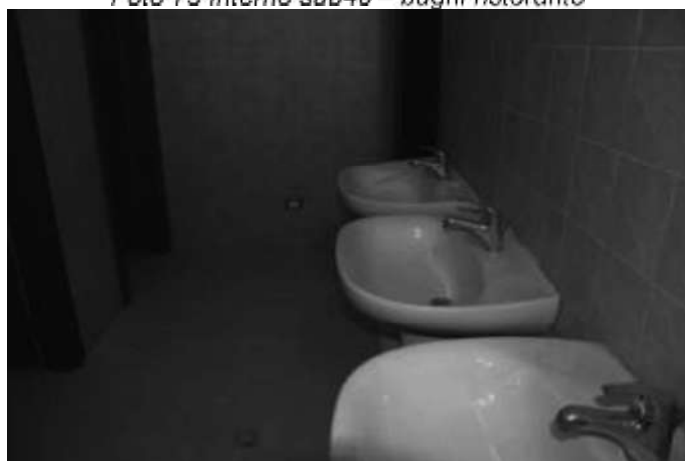
Foto 75 Interno sub40 – bagni ristorante
