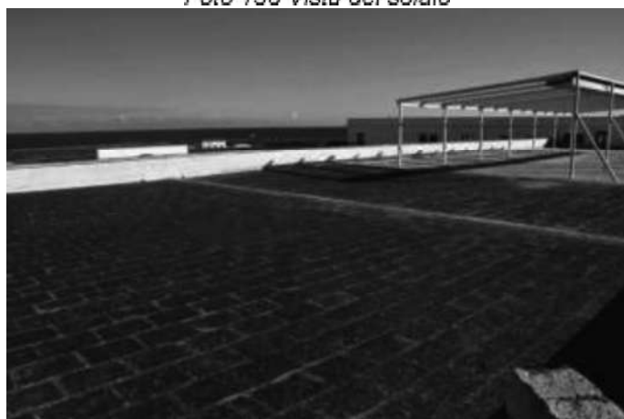
Foto 140 Vista del solaio
