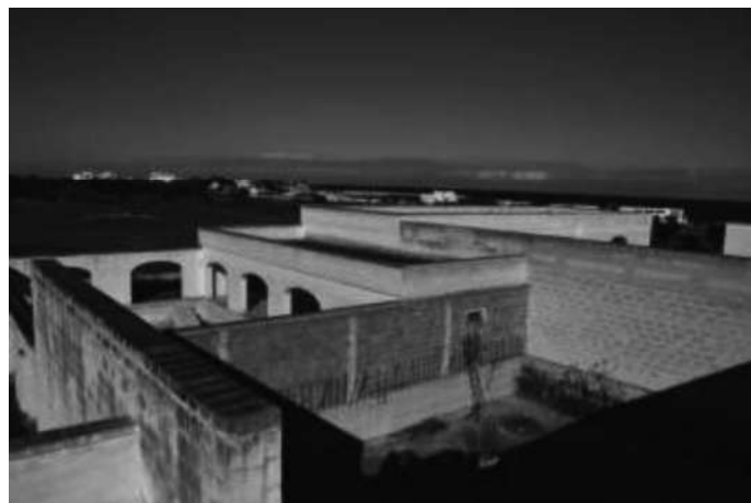
Foto 144 Vista dall'alto della piscina in costruzione
