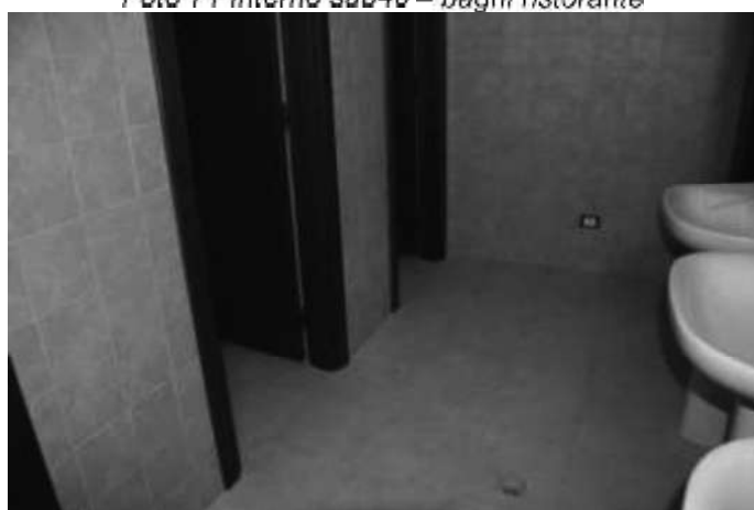
Foto 73 Interno sub40 – bagni ristorante
