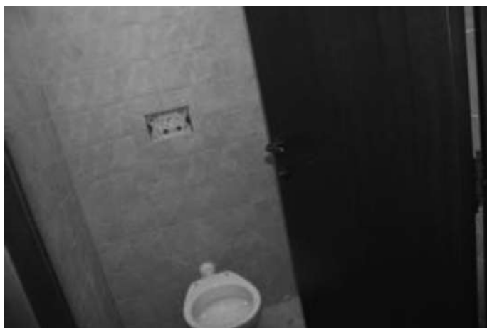
Foto 68 Interno sub40 – bagni ristorante
