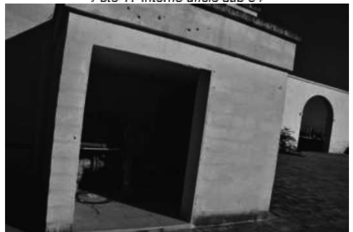
Foto 19 Vano tecnico retrostante ufficio sub 34
