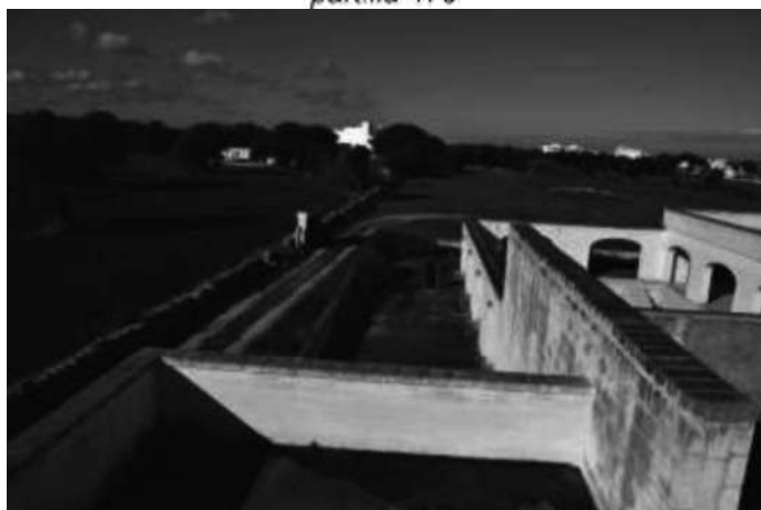
Foto 143 Vista dell'area pavimentata sub 38 e stradina part.IIa 470
