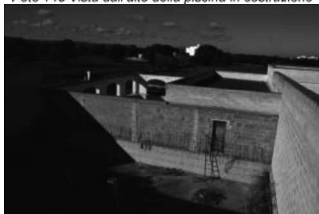
Foto 147 Vista dall'alto della piscina in costruzione
