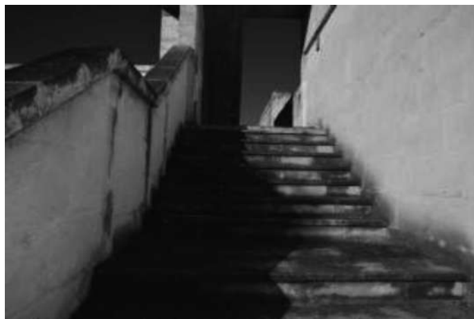
Foto 134 Vista della scala solaio
