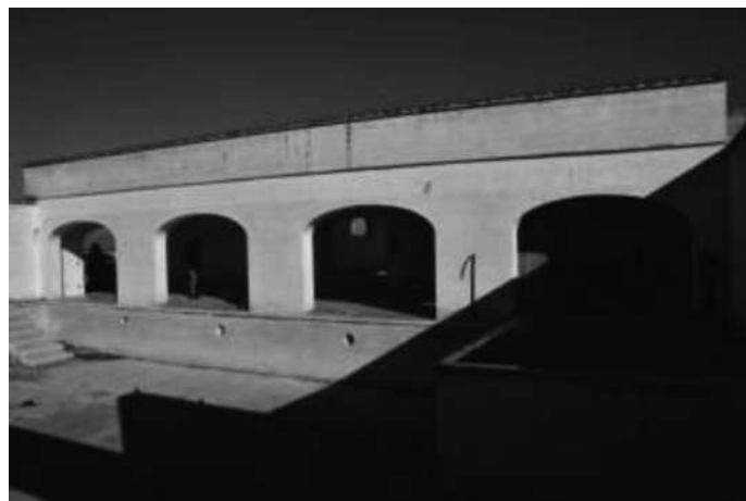
Foto 101 Sub42 – Piscina scoperta
