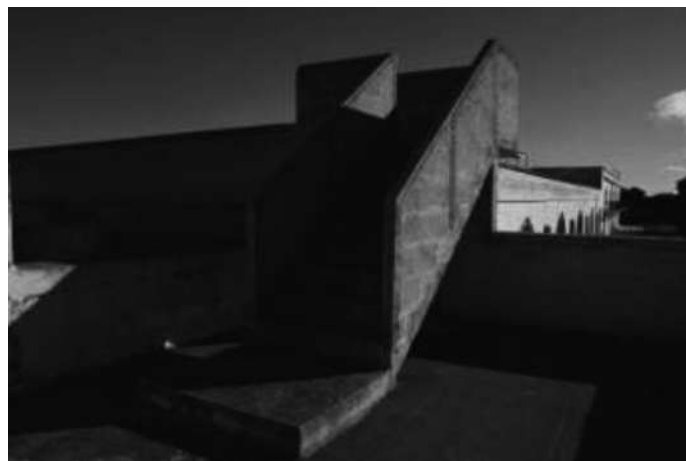
Foto 142 Vista della scala solaio
