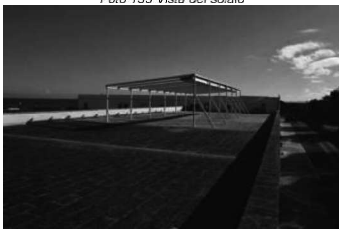
Foto 135 Vista del solaio
