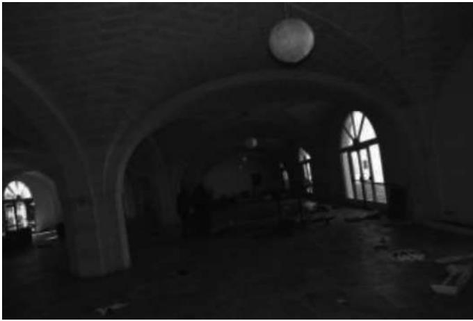
Foto 20 Interno Sala ristorante, portico sub 40
