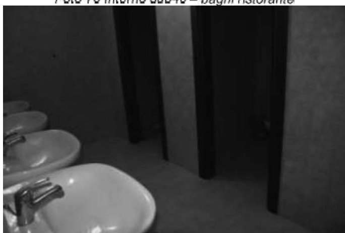
Foto 72 Interno sub40 – bagni ristorante
