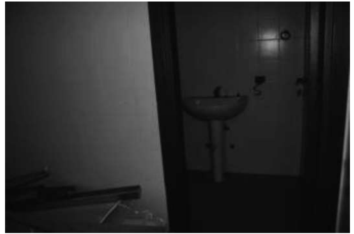
Foto 93 Interno sub 40 – cucine ristorante, bagni
