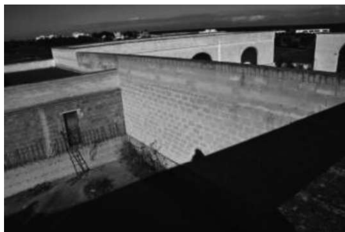
Foto 146 Vista dall'alto della piscina in costruzione
