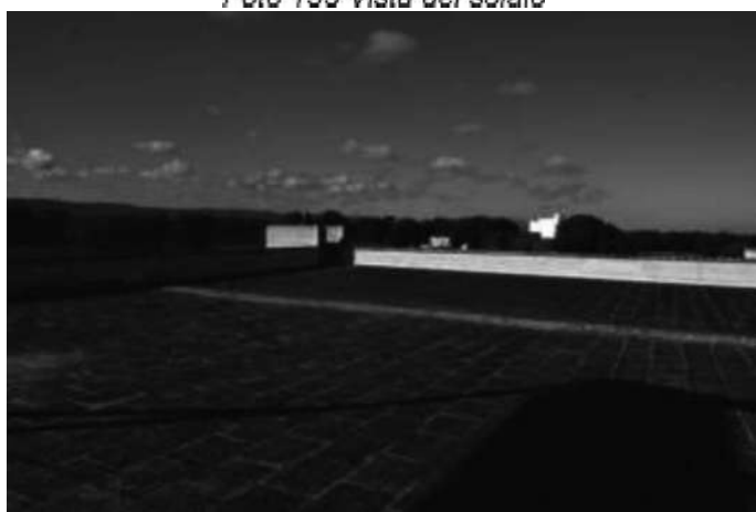
Foto 137 Vista del solaio
