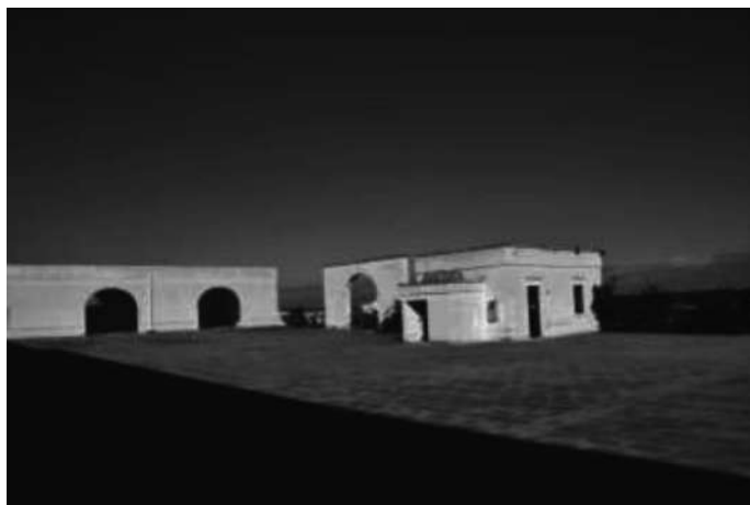
Foto 4 Ufficio sub34 e piazzale sub38
