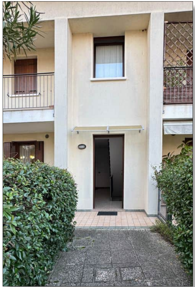
Foto n. 02) Vista dell'ingresso comune
