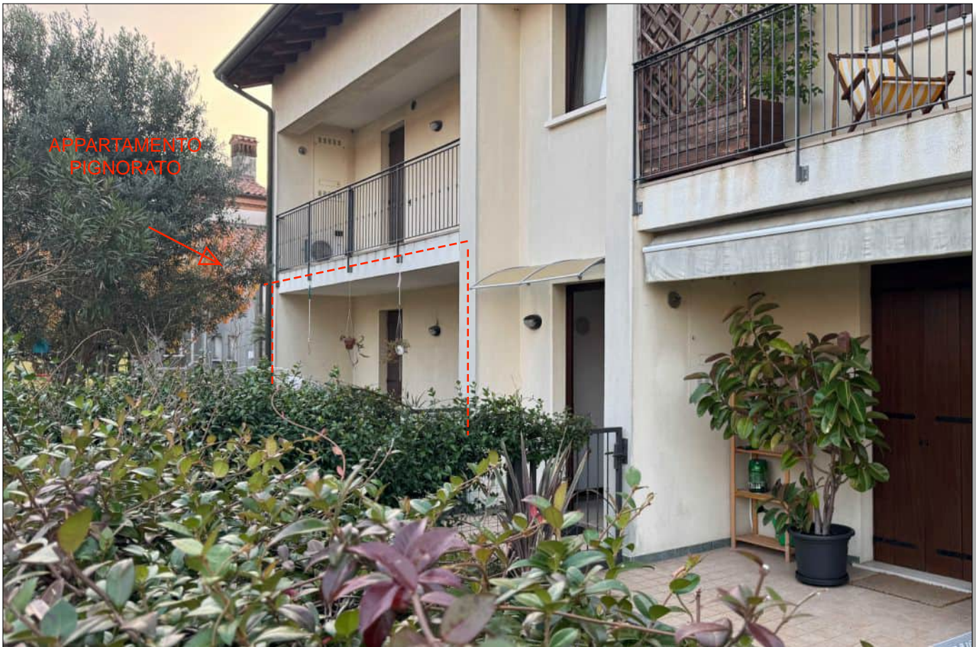
Foto n. 05) Vista del prospetto est
