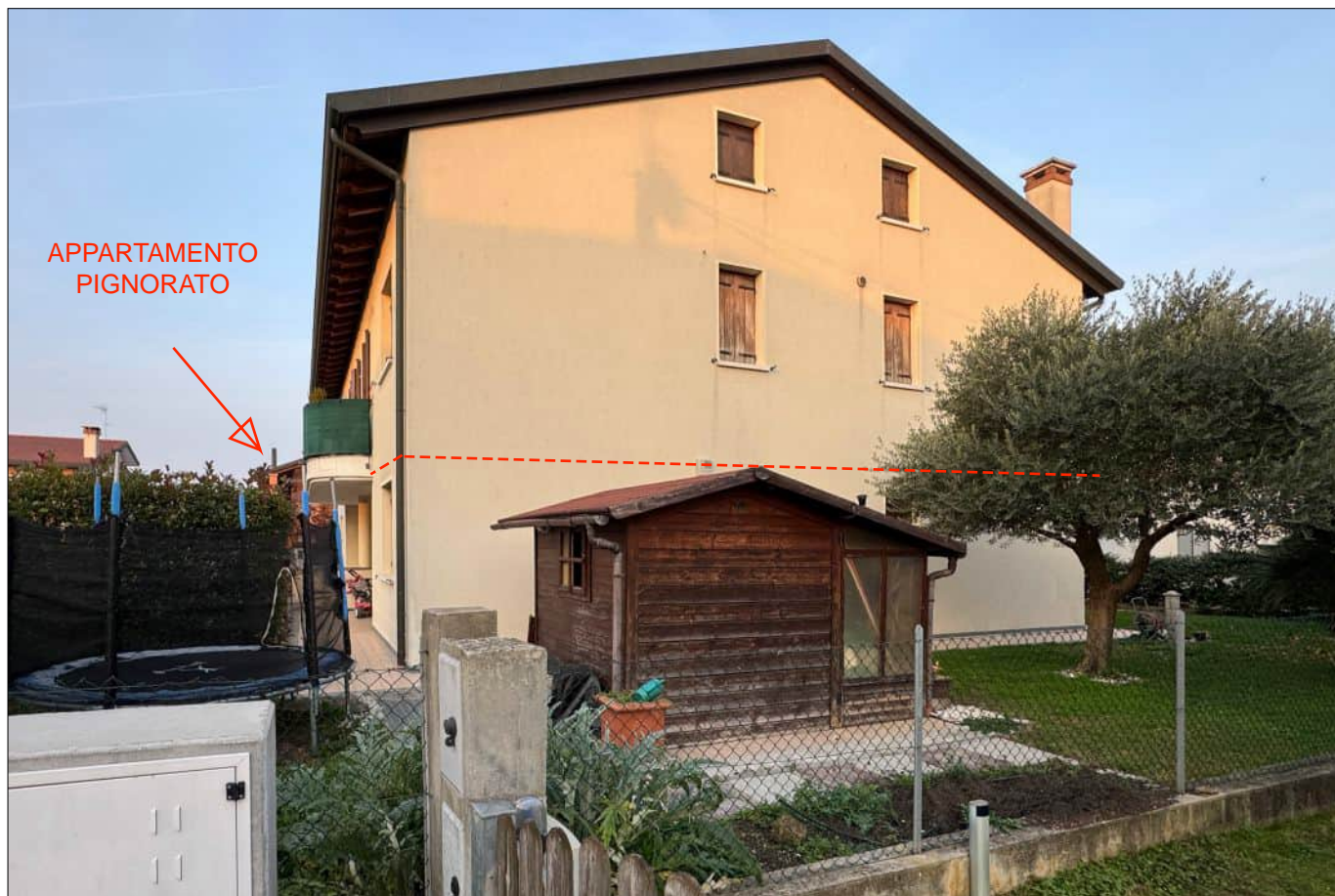
Foto n. 6) Vista dei prospetti sud ed ovest
