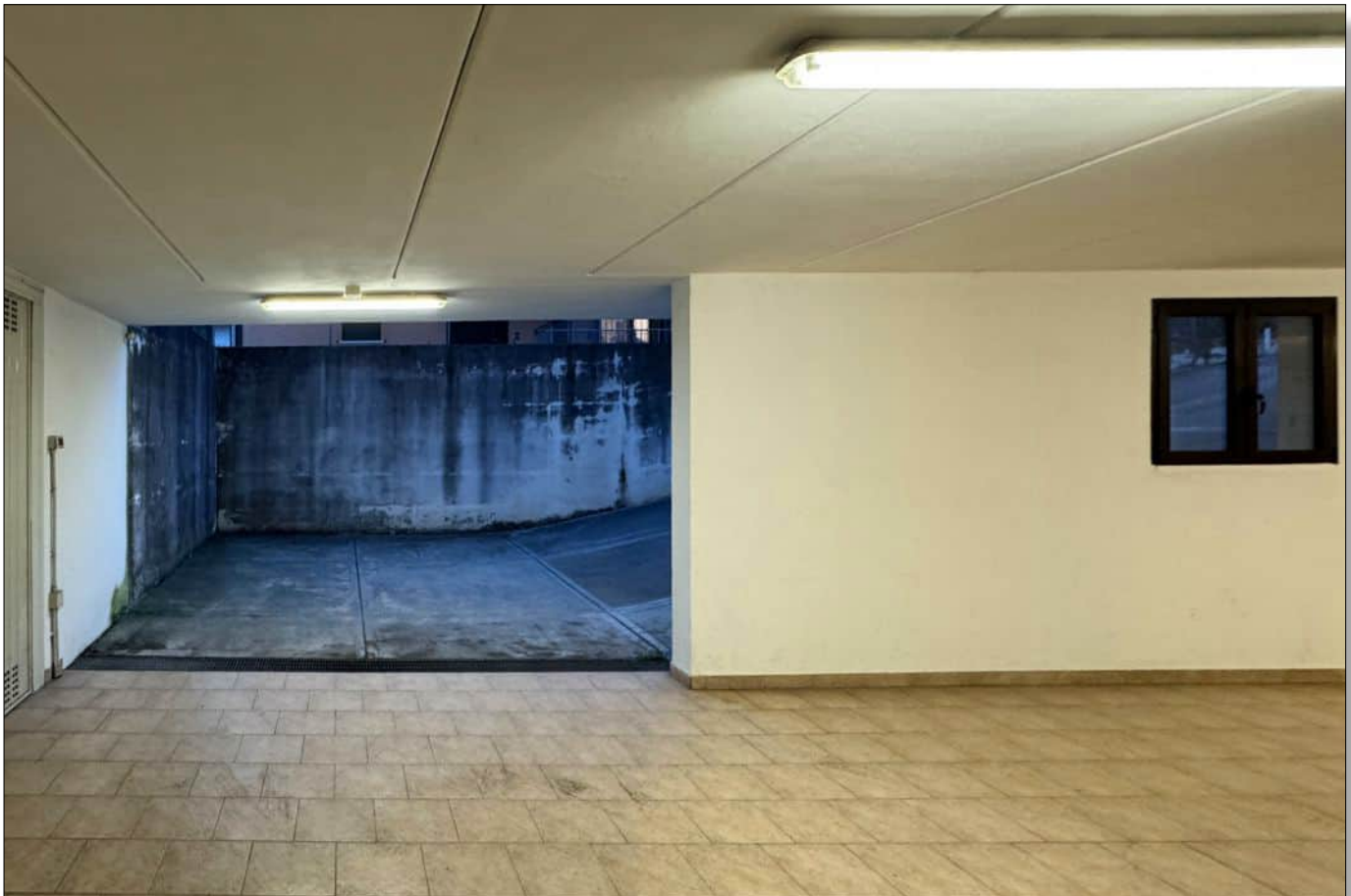
Foto n. 21) Vista della rampa di accesso ai garages
