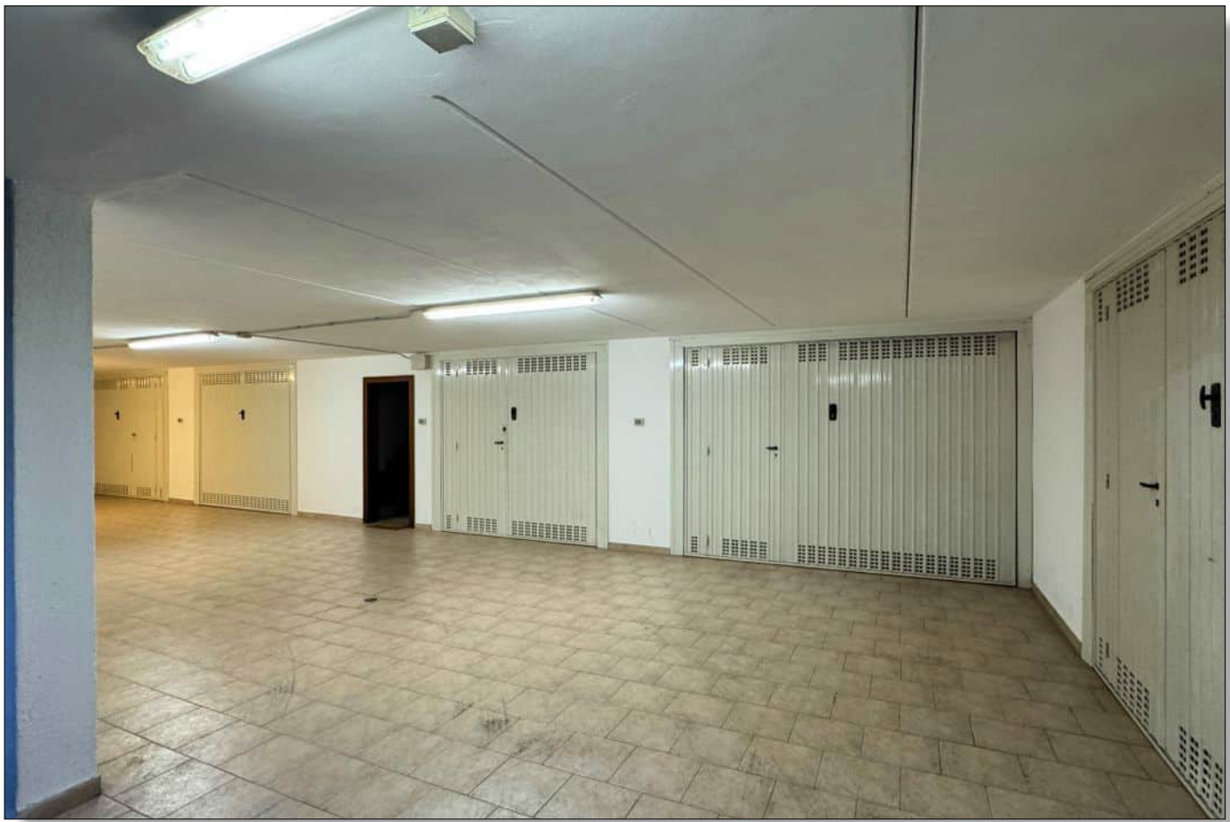
Foto n. 22) Vista dell'area di manovra piano garages
