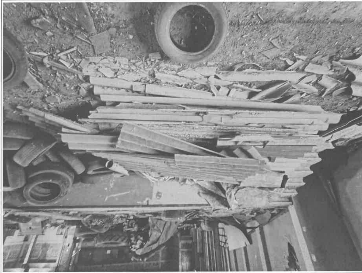
Foto n°10: lastre fibrocemento privo di amianto
