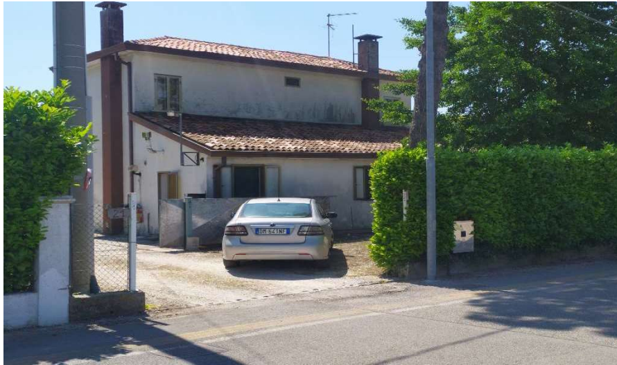
FOTO N. 3: abitazione - LOTTO N. 2
