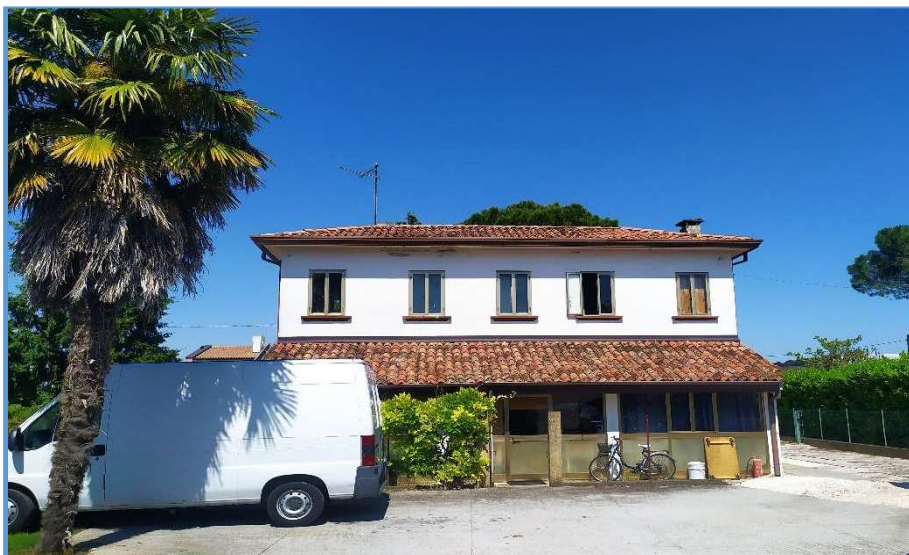
FOTO N. 5: abitazione - LOTTO N. 2
