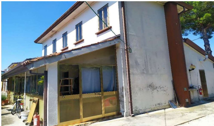
FOTO N. 4: abitazione - LOTTO N. 2
