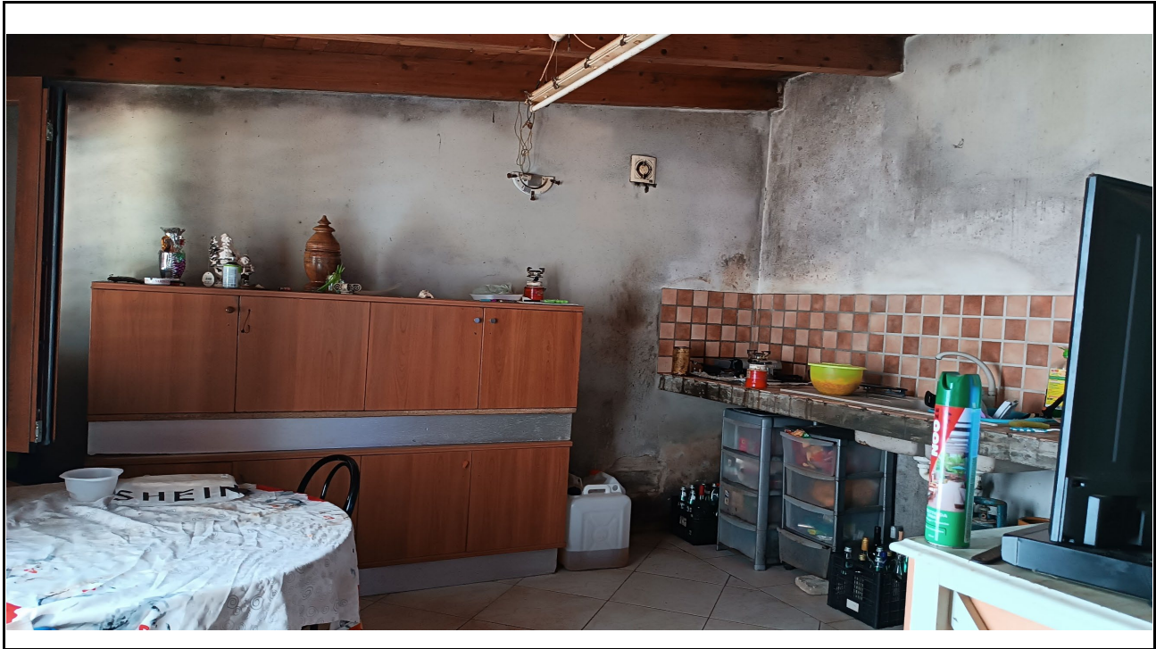
Foto n°19 - Piano terra: cucina
