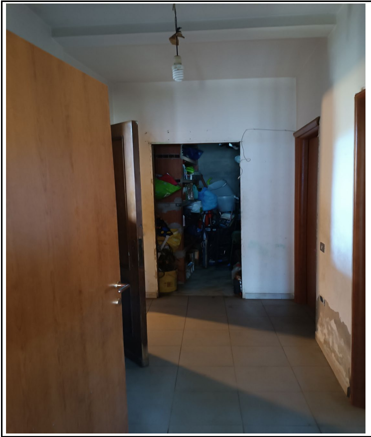
Foto n°13 - Piano terra: camera
