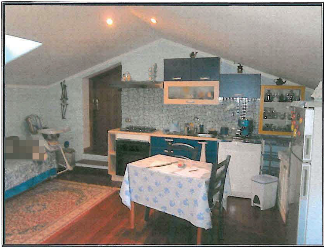
Viste interne del sottotetto realizzato in difformità al titolo
