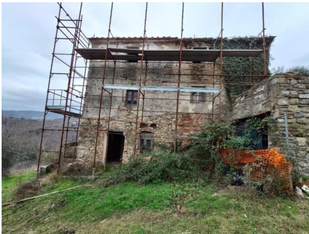
Foto 18 – ingresso seminterrato e resede
