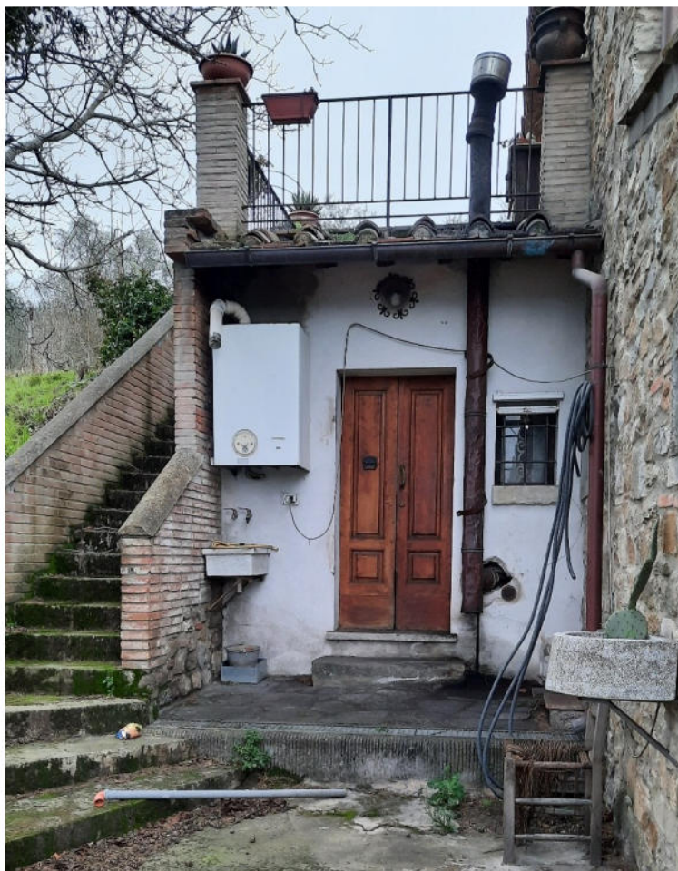
Foto 25 – manufatti realizzati sulla Part. 23
