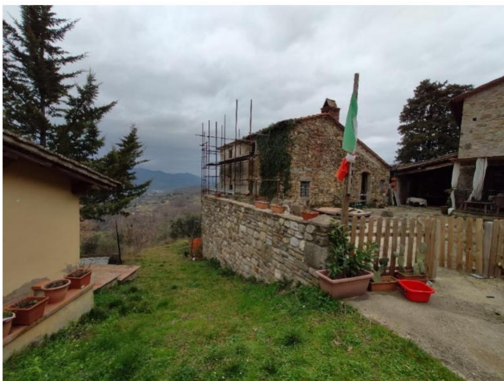
Foto 16 – insieme degli edifici
