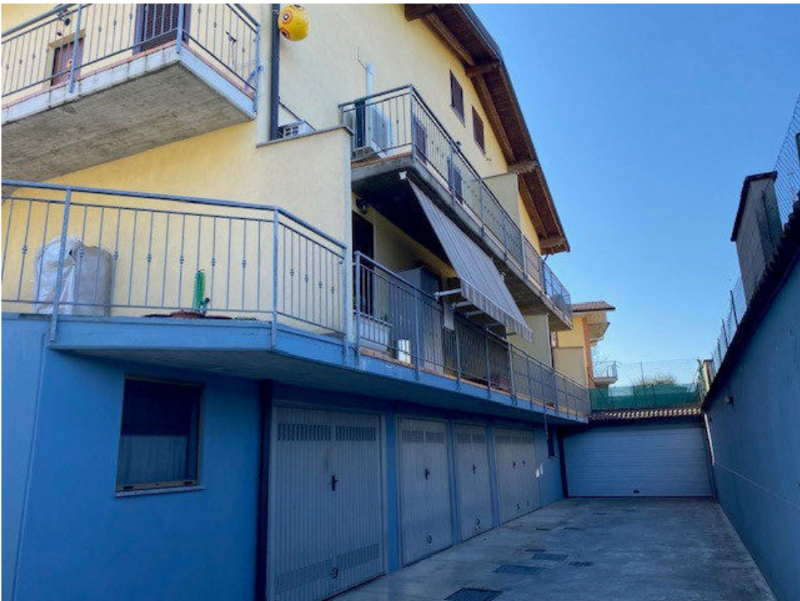
corsello interno / prospetto ovest
