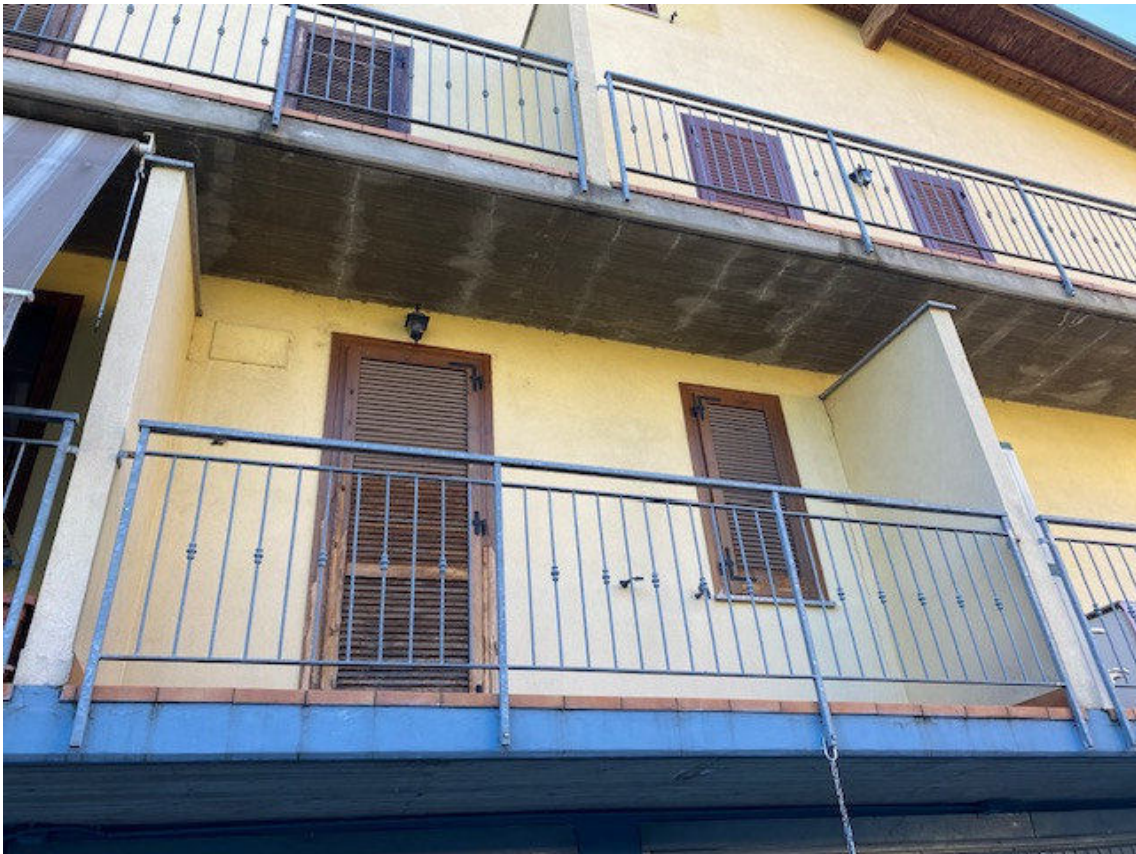
prospetto ovest appartamento / balcone
