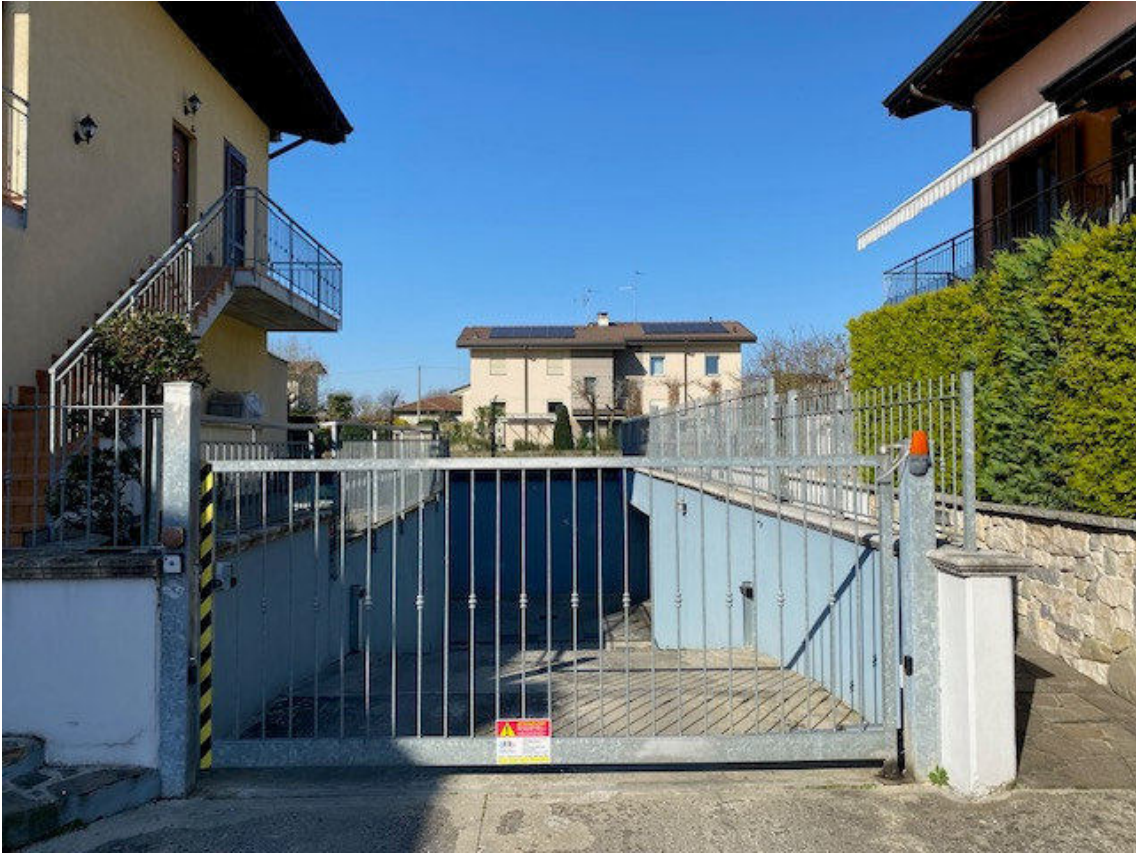
accesso carrale al corsello interno
