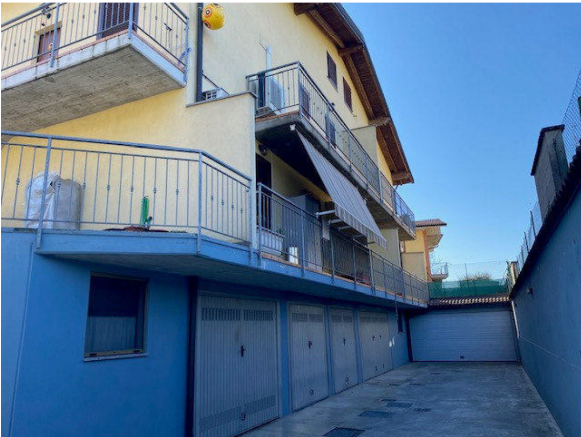
corsello interno / prospetto ovest
