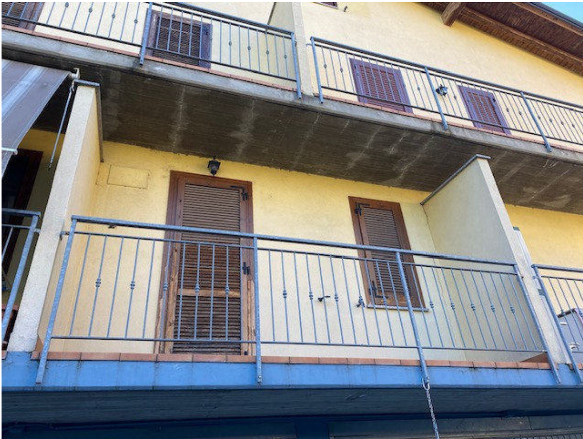
prospetto ovest appartamento / balcone
