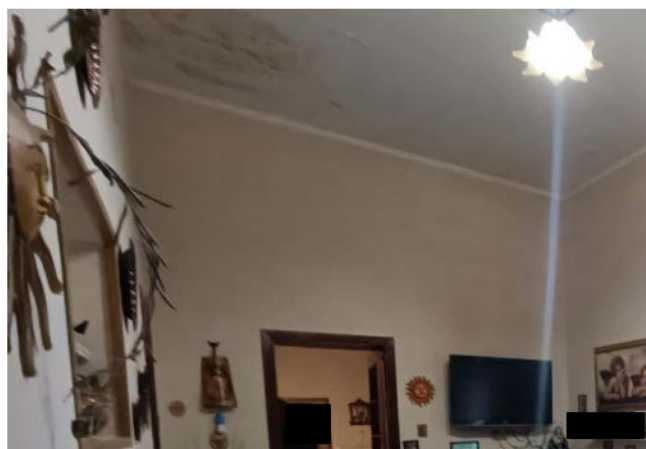
FOTO 18: Macchie di umidità discendente nelle camere 6 e 4 dovute a guasti nell'impermeabilizzazione di copertura
