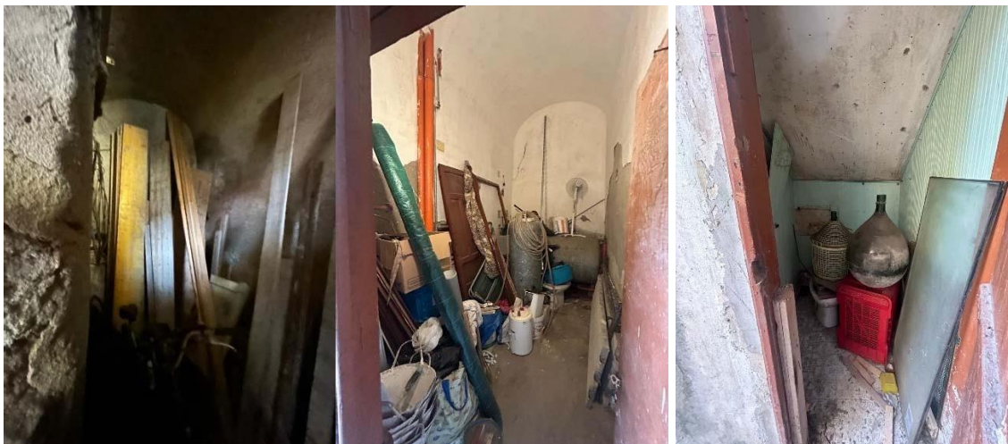
Foto 5-Foto 6-Foto 7: Deposito n. 3, e deposito n. 4 e deposito n. 5
