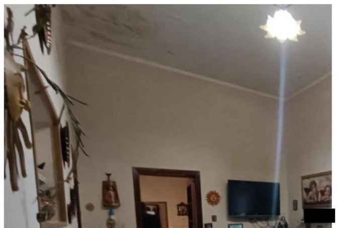
FOTO 18: Macchie di umidità discendente nelle camere 6 e 4 dovute a guasti nell'impermeabilizzazione di copertura
