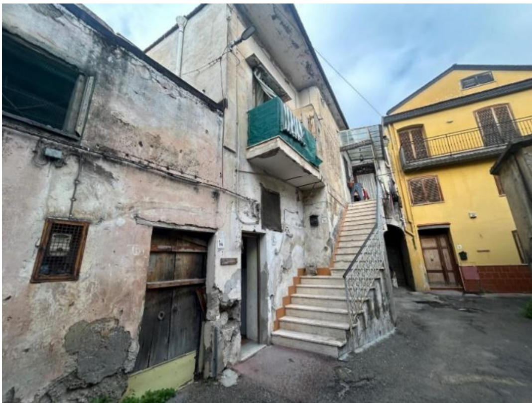
FOTO 1: Vista dell'immobile dall'interno del cortile nel quale è collocato, sono visibili sulla sinistra dell'immagine la scala che conduce al I livello e il portoncino di ingresso, nonché l'ingresso di uno dei depositi a piano terra e il balconcino in I livello –
