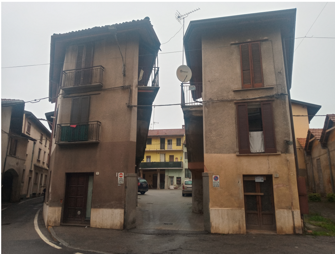
Foto n. 1 - Vista della corte da via Montello
