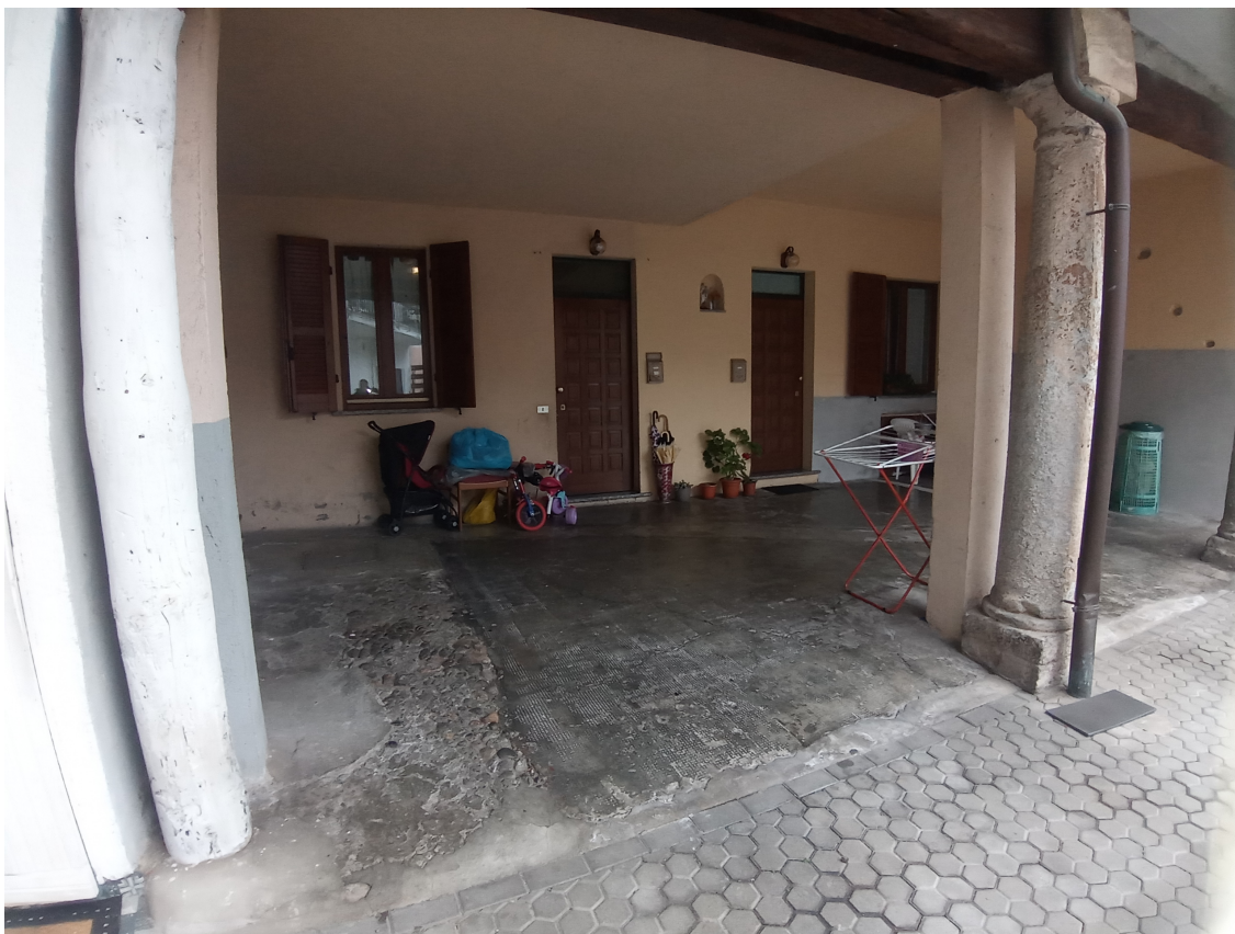
Foto n. 14 - Vista del posto auto coperto esterno
