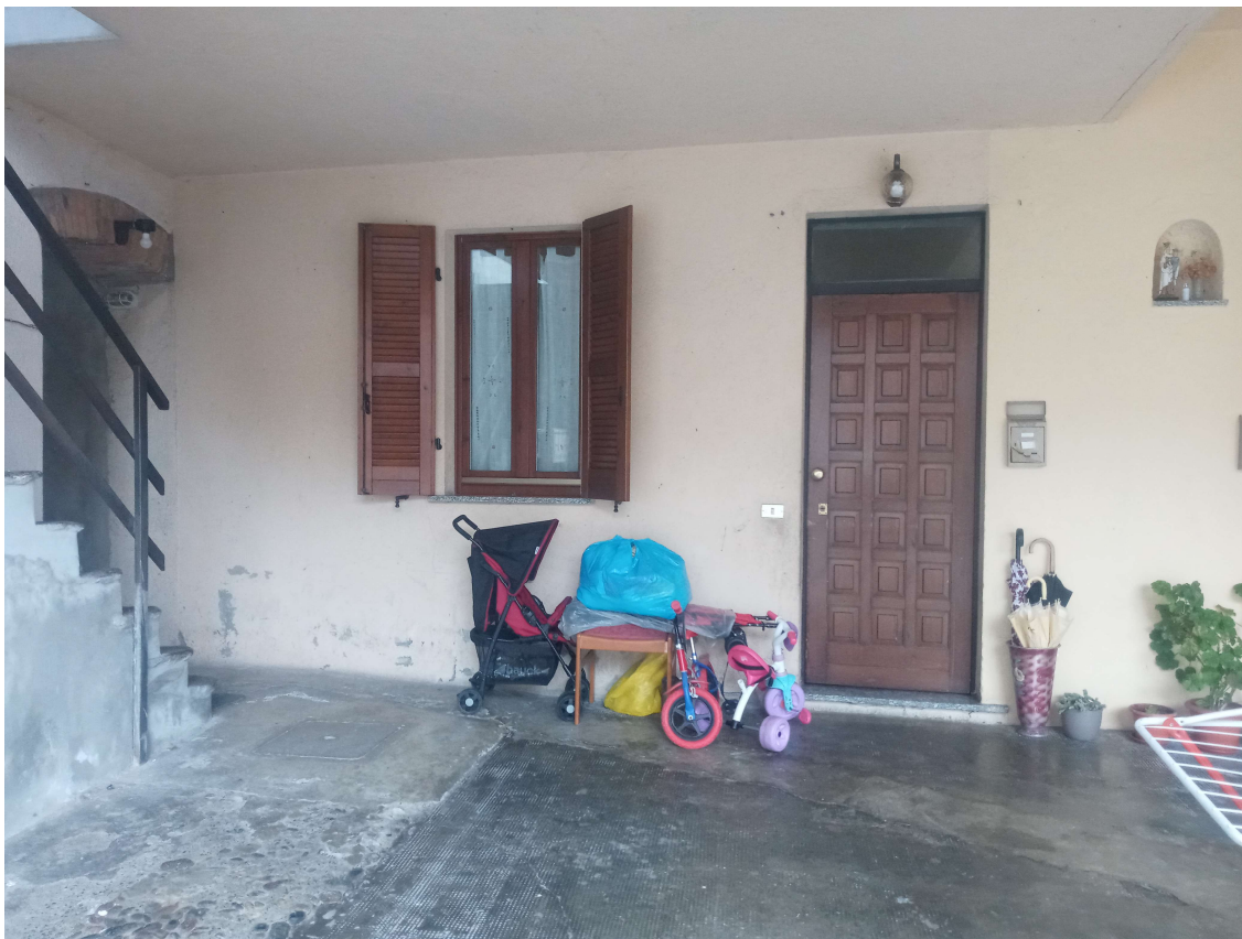
Foto n. 3 - Vista dell'ingresso all'appartamento
