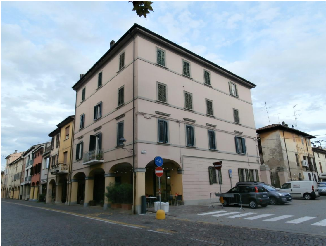
SAN GIORGIO DI PIANO, via Libertà n. 112
