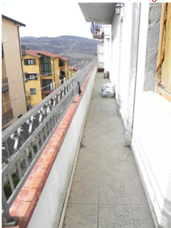
Balcone che accede al terrazzo coperto
