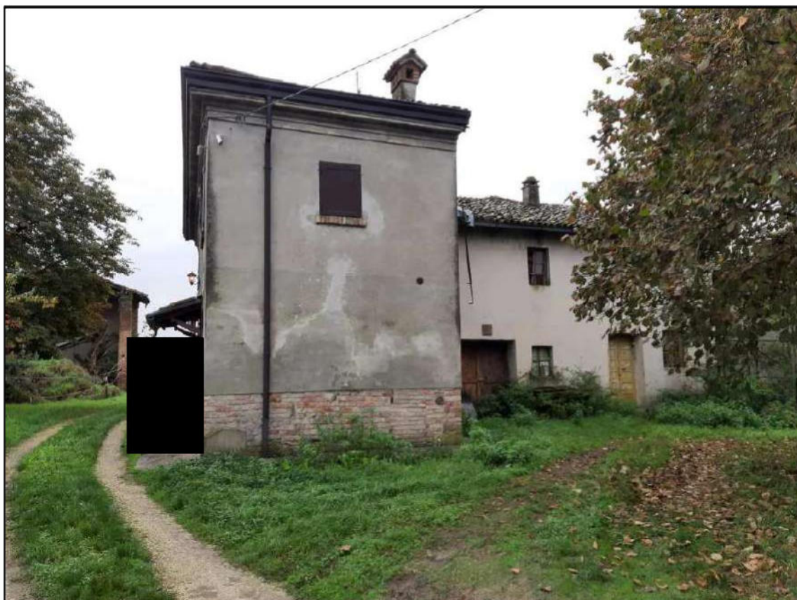
F 2 - Fronte Nord
