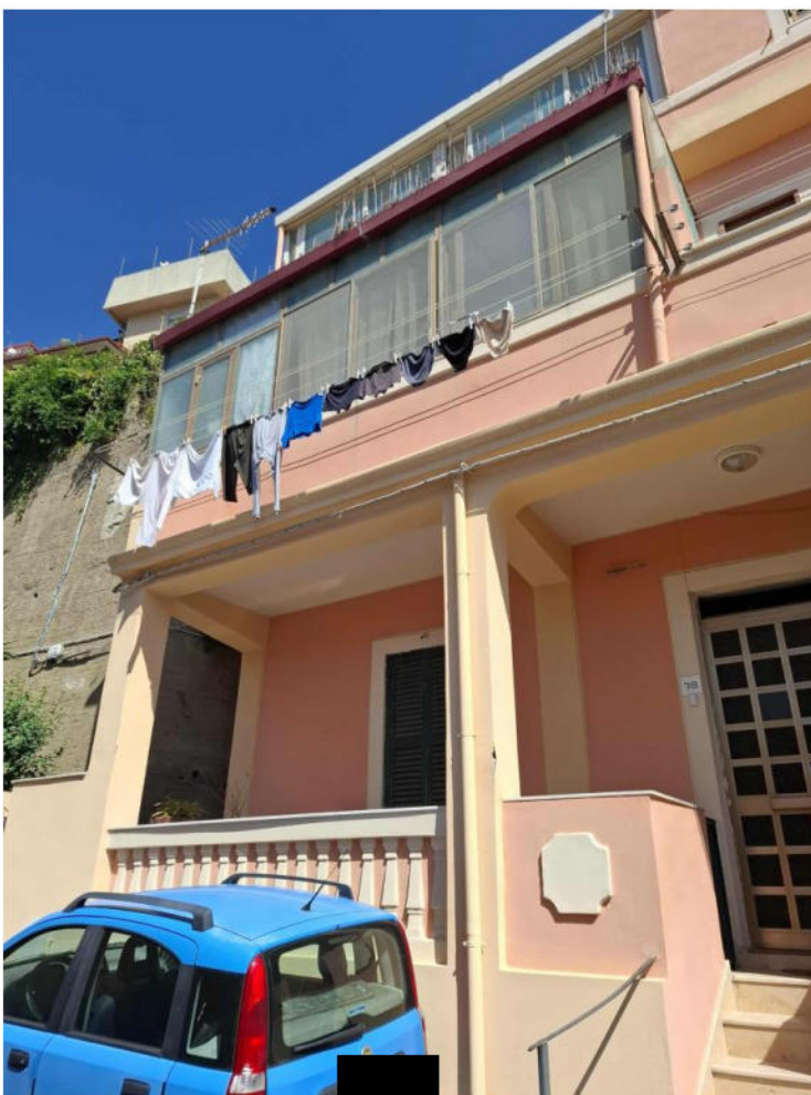
Foto 1 e 2 “Particolare del prospetto su via del Santo”
