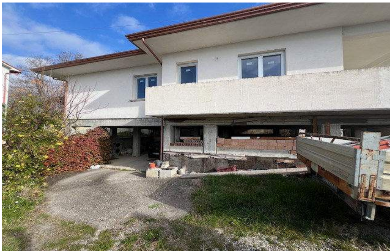
VISTA DEL FABBRICATO DEL PROSPETTO SUD/OVEST – LOTTO N. 1 CORPO A
