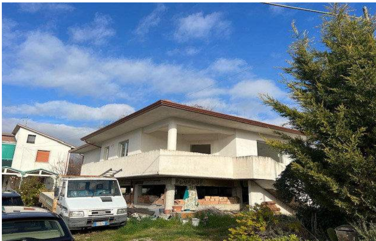
VISTA DA VIA IGNAZIA DEL FABBRICATO LOTTO N. 1 CORPO A – FG. 28 P.LLA 1794 COMUNE DI PADULI
