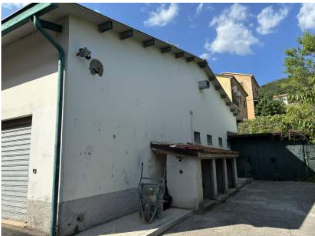
Foto 03 – Fronte posteriore dell'immobile commerciale al fg.18 n.603 (lotto n.10).
