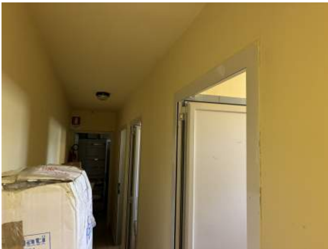
Foto 10 – Zona locali accessori dell'immobile commerciale al fg.18 n.603 (lotto n.10)
