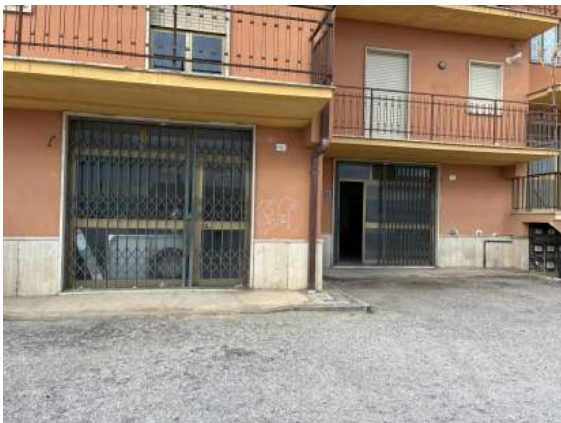
Foto 01 -I due ingressi del locale commerciale sub.2 (lotto n.9) dalla corte comune al mappale 483
