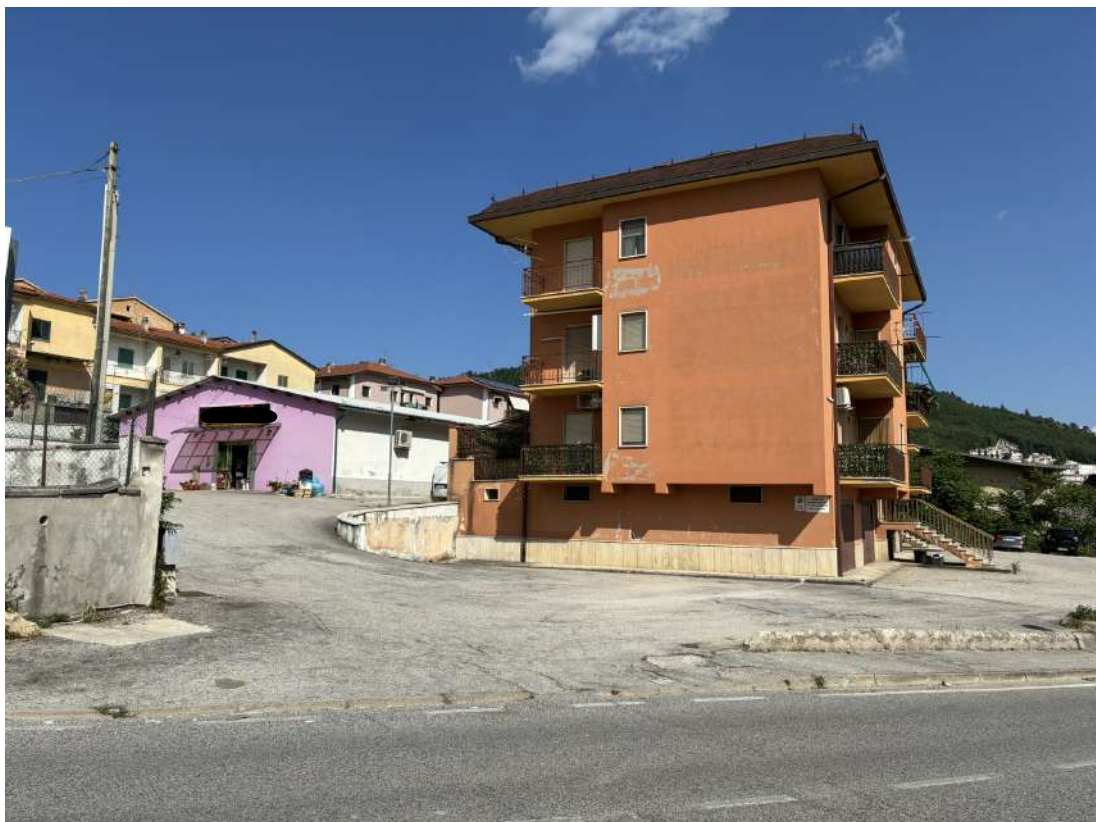
Foto 01 -Accesso al complesso edilizio da via Sardellino attraverso la particella n.419 (lotto 11). In primo piano il palazzo distinto al mappale 483 e, in fondo, il locale commerciale distinto al mappale 603.
