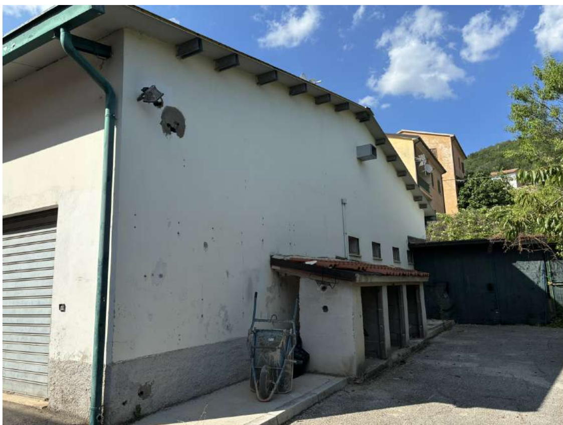
Foto 08 – vista posteriore del locale commerciale distinto al mappale n.603 (lotto 10)
