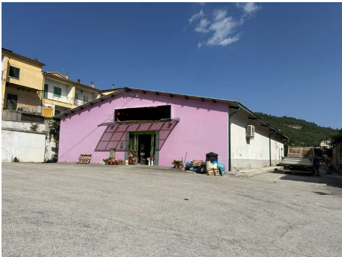
Foto 06 – vista anteriore del locale commerciale distinto al mappale n.603 (lotto 10)
