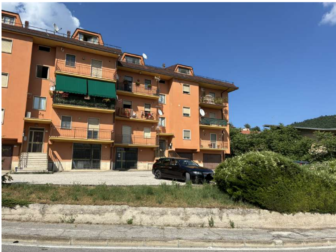
Foto 03 – vista anteriore del palazzo distinto al mappale 483.
