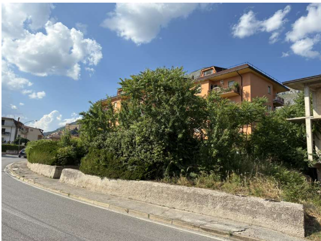
Foto 04 – vista laterale del palazzo distinto al mappale 483.
