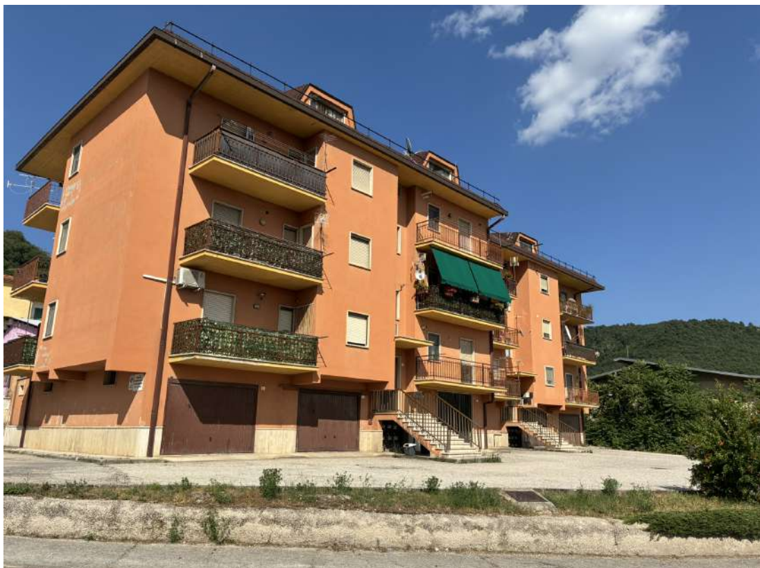
Foto 02 – vista anteriore del palazzo distinto al mappale 483.
