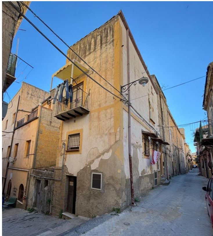
Foto n. 1 – Vista dell’immobile oggetto di stima dalla via Magri
