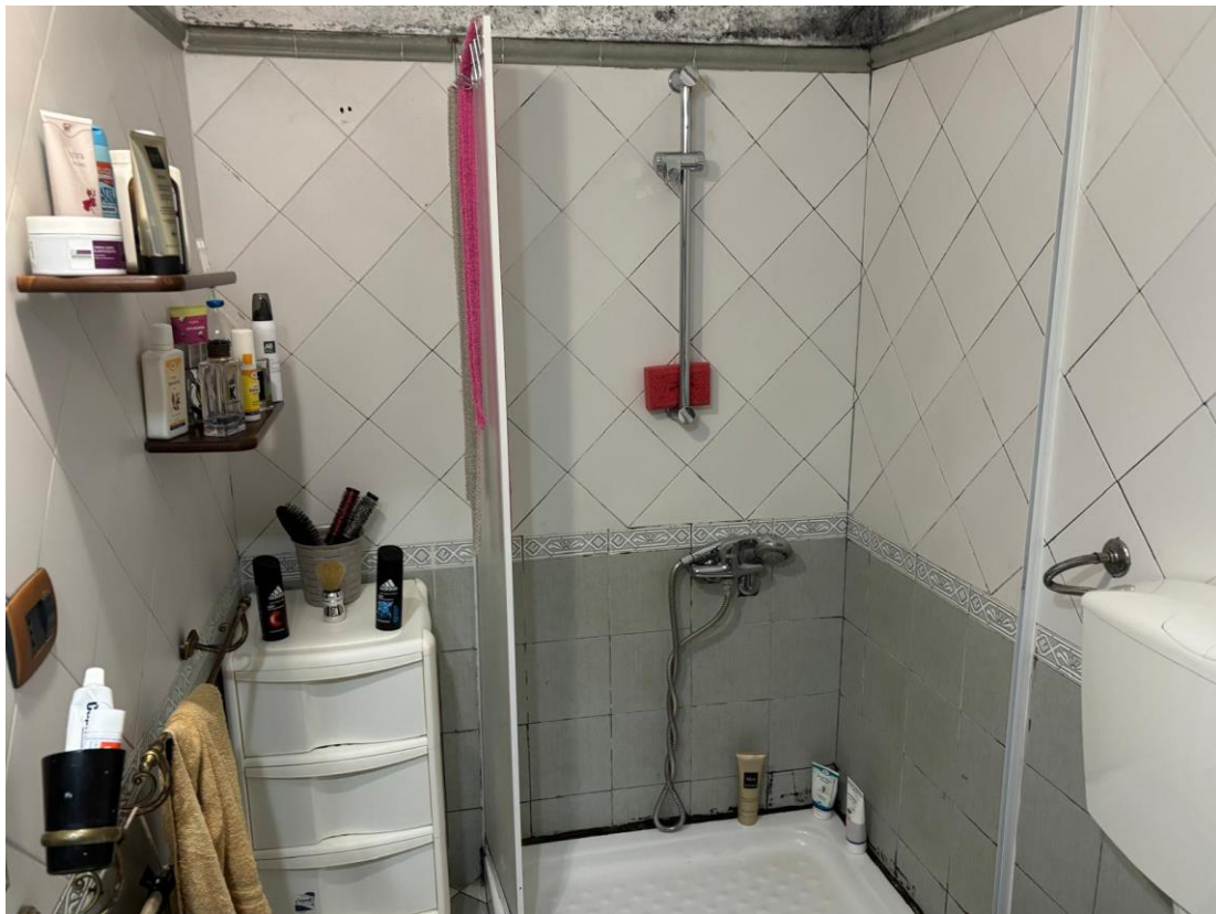
Foto n. 6 – Vista del bagno dell'unità immobiliare
