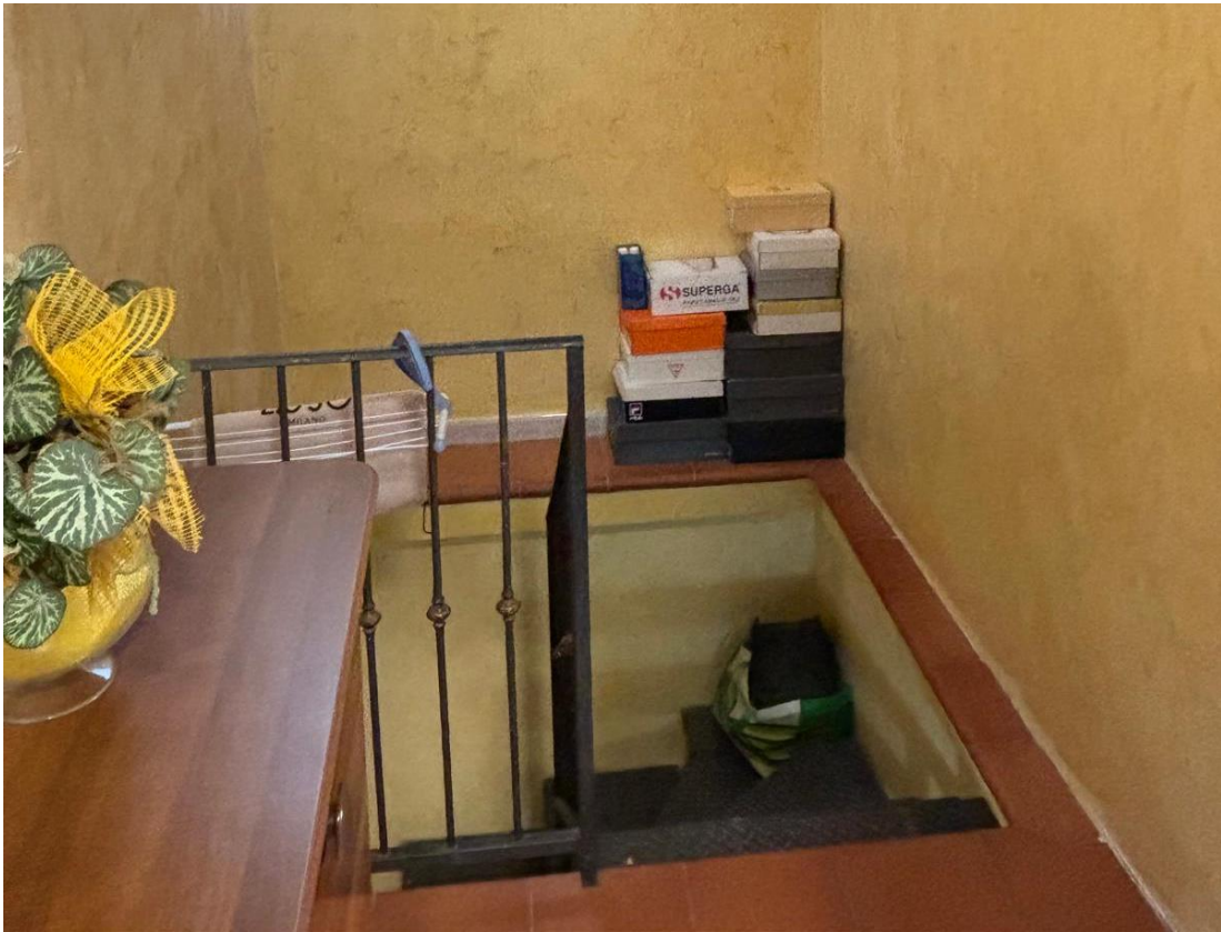
Foto n. 15 – Vista della scala interna e del pianerottolo di arrivo al piano secondo
