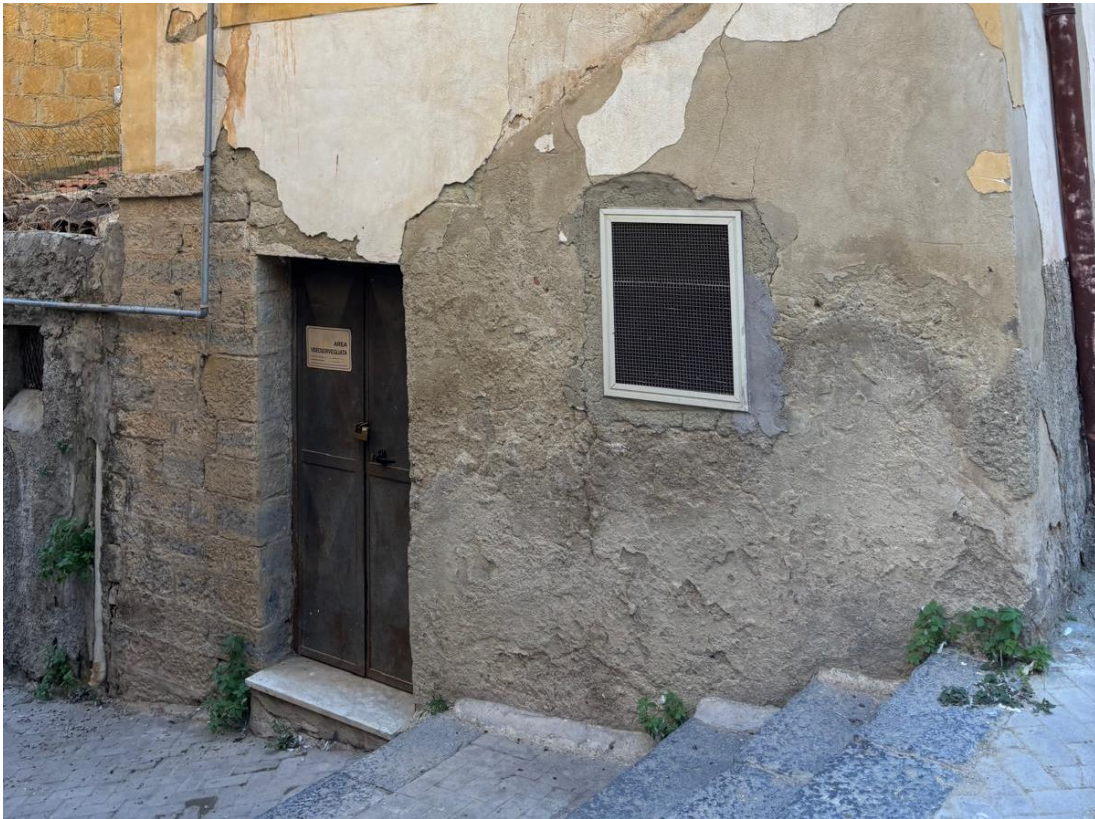
Foto n. 21 – Vista della porta di ingresso al piano seminterrato, ubicata in via Saccarella
