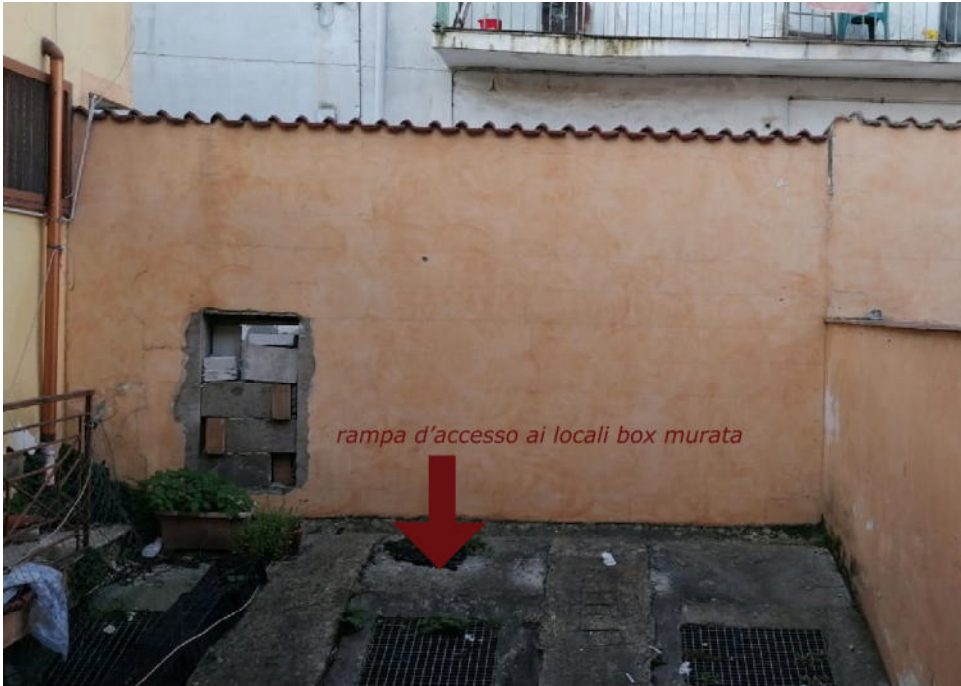
Visione lato interno rampa
