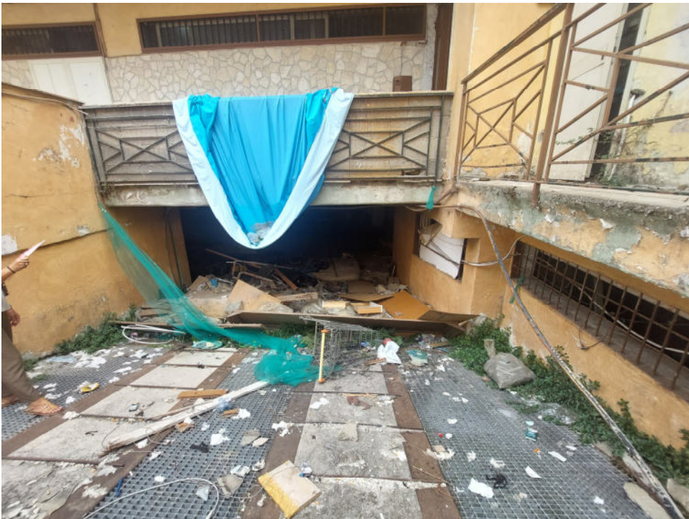
Rampa d'accesso all'area interrata (situazione al 09/09/2025)
