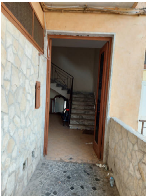
Vano scala B
