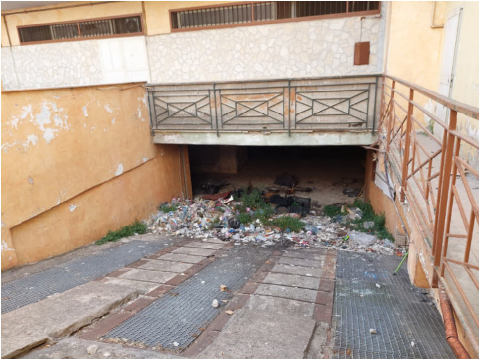
Rampa d'accesso all'area interrata (situazione all'anno 2022)
