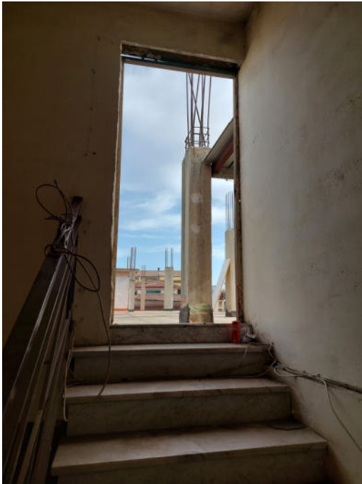
Vano scala B
