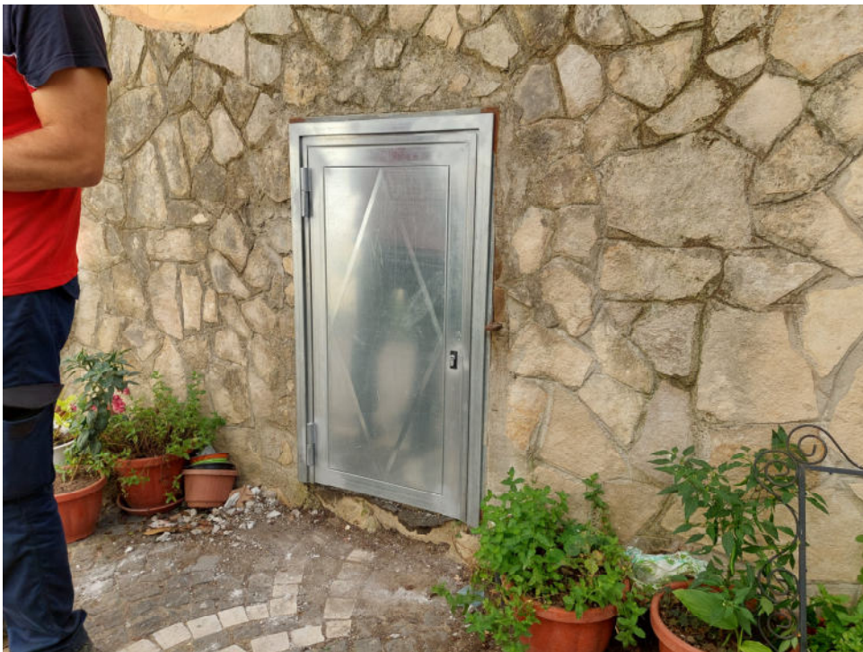
Porta di ferro realizzata per accesso esclusivamente pedonale
