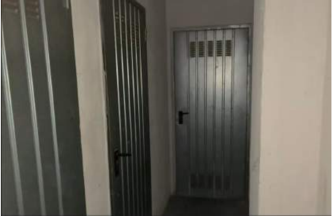
Foto 07 – Di fronte la porta della cantina dell'appartamento sub.20 (lotto n.8).
