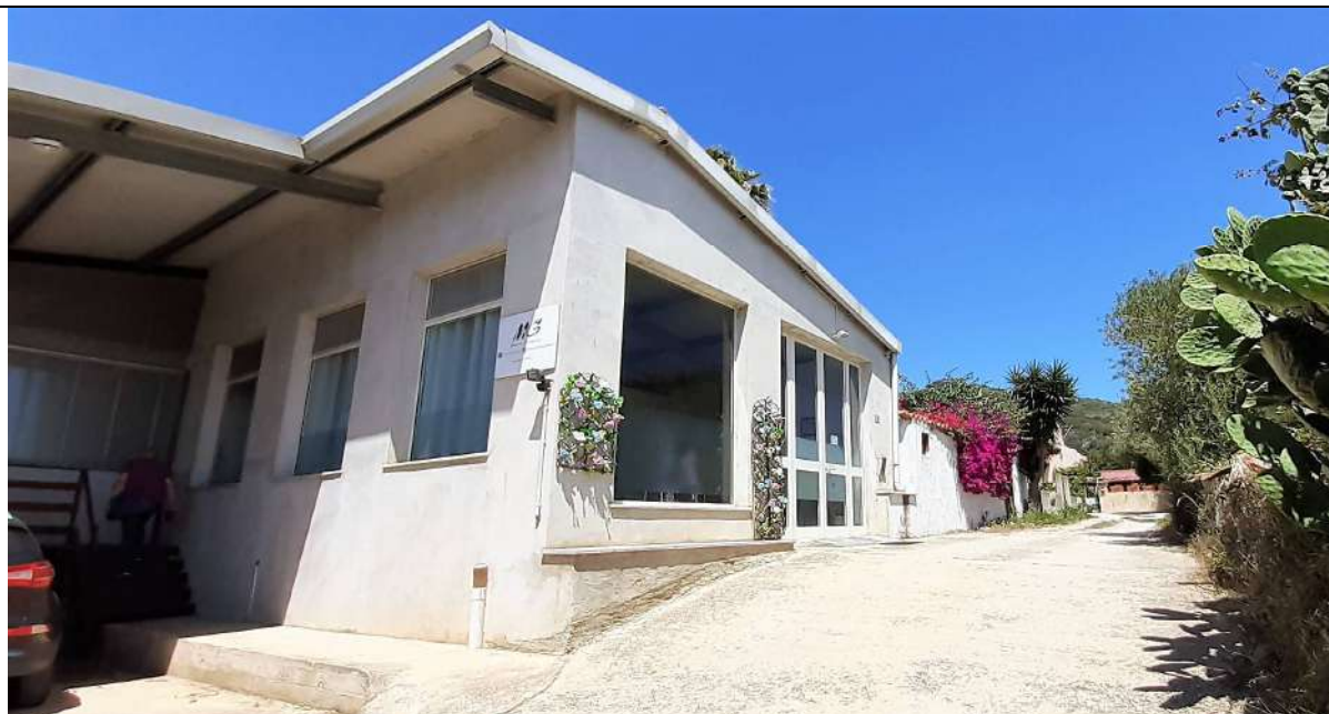
2. Vista Atelier. Accesso dalla via A. Volta
