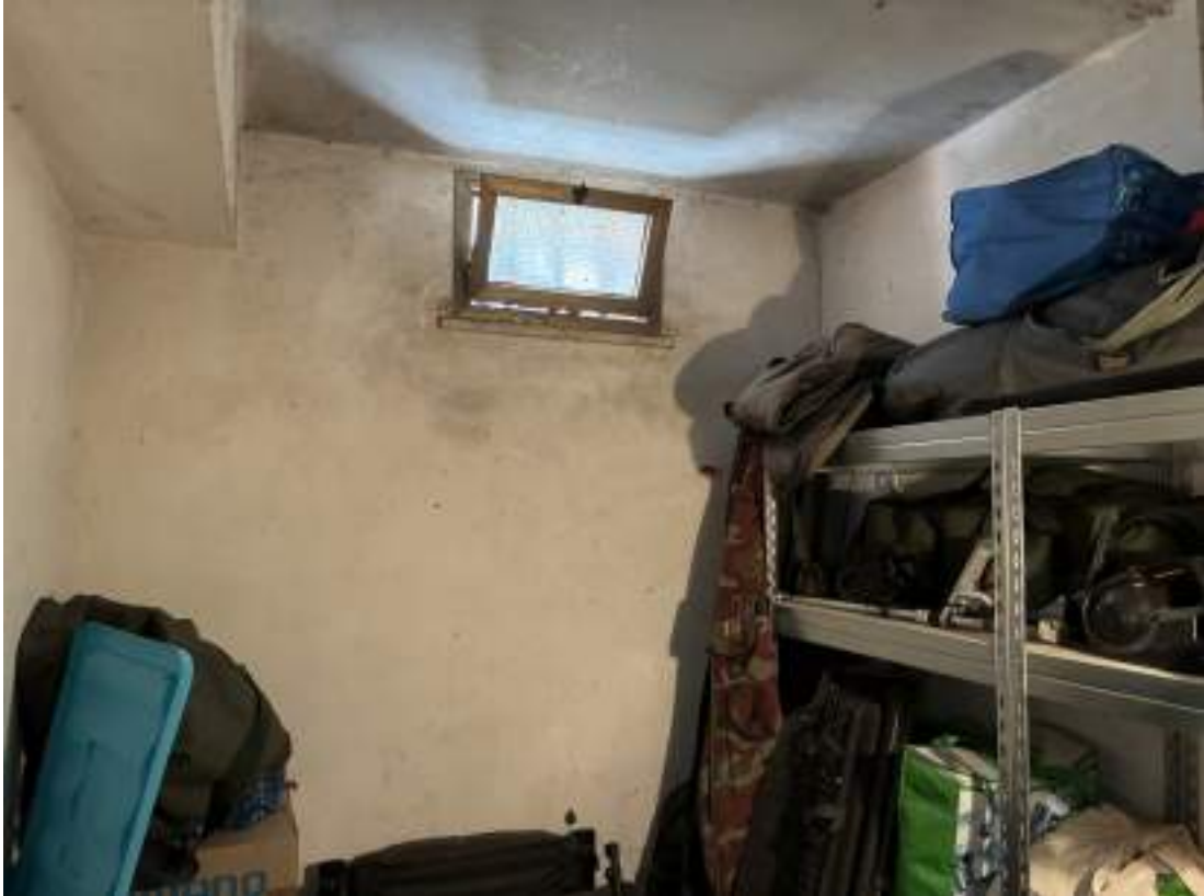
Foto 09 – Cantina dell'appartamento sub.19 (lotto n.7
