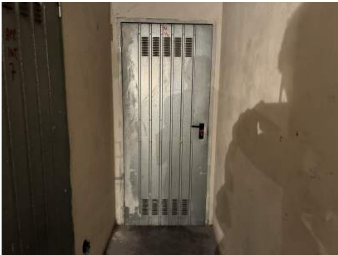
Foto 07 – Di fronte l'ingresso della cantina dell'appartamento sub.12 (lotto n.4).
