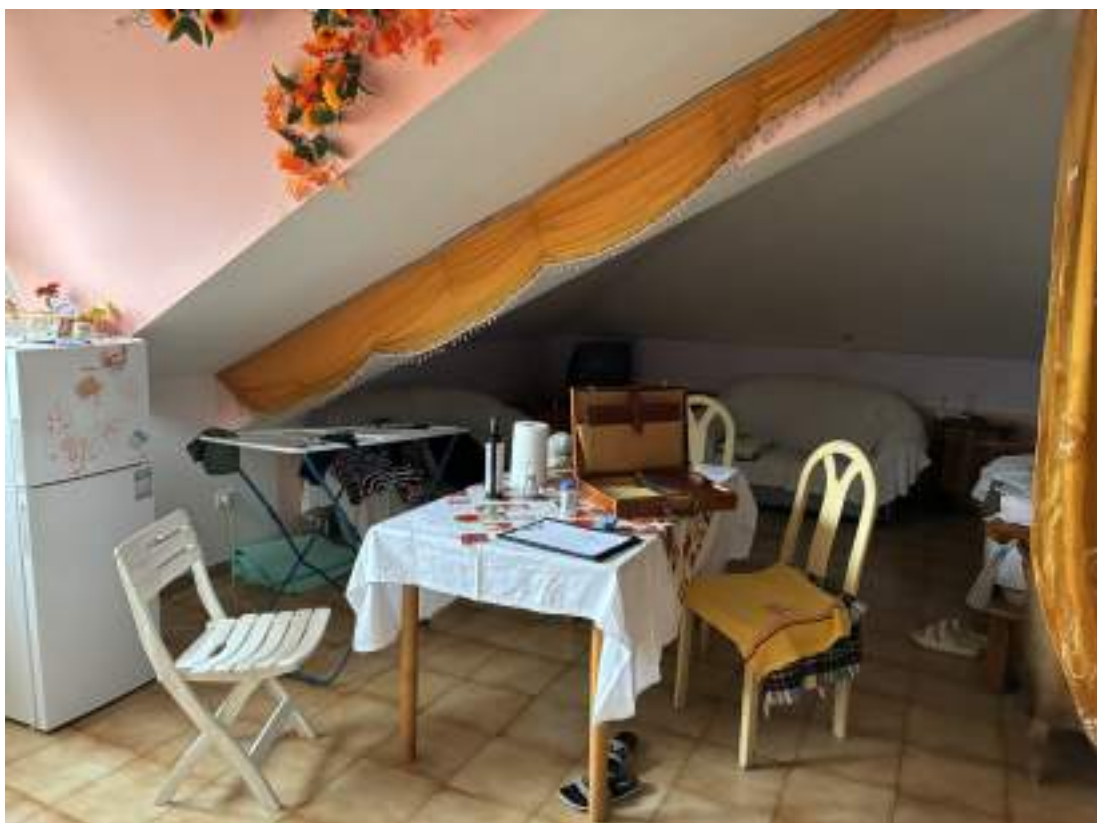
Foto 03 – Zona di ridotta altezza del pranzo soggiorno dell'appartamento sub.11 (lotto n.3)
