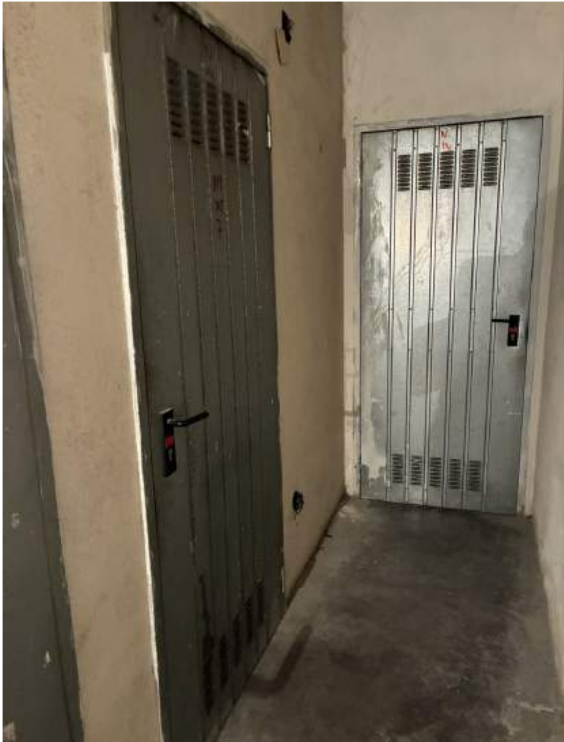
Foto 07 – lato la porta della cantina dell'appartamento sub.11 (lotto n.3).
