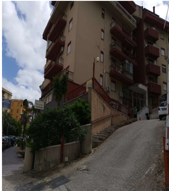
Foto n.2 Prospetto dalla traversa di via Imera
