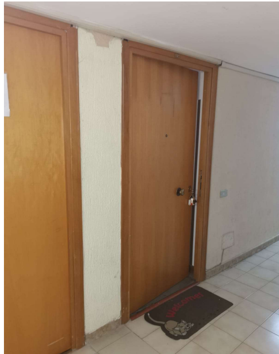
Foto n° 6 Porta di ingresso all'unità
