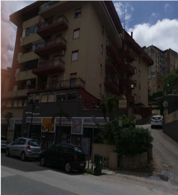
Foto n.1 Prospetto dalla via Imera
