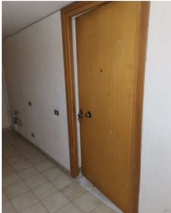
Foto n° 6 Porta di ingresso all'unità
