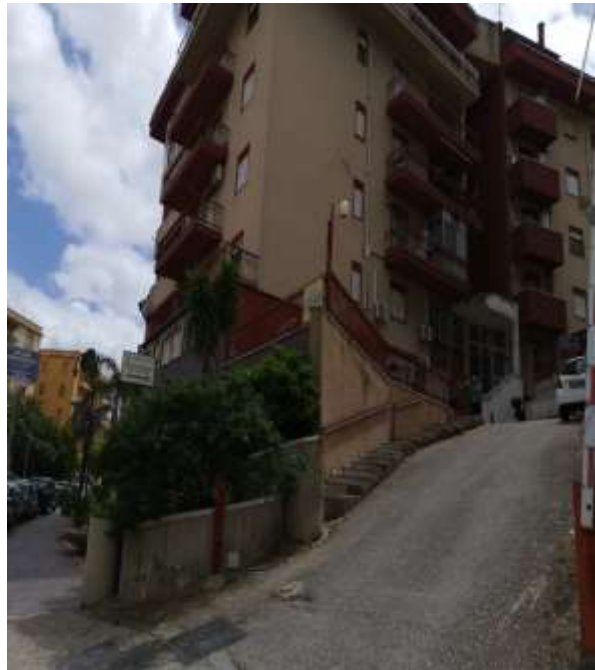
Foto n.2 Prospetto dalla traversa di via Imera
