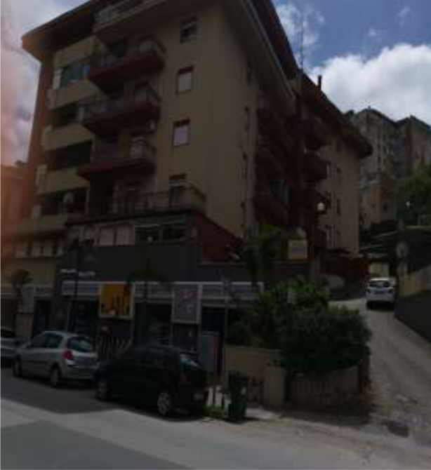
Foto n.1 Prospetto dalla via Imera
