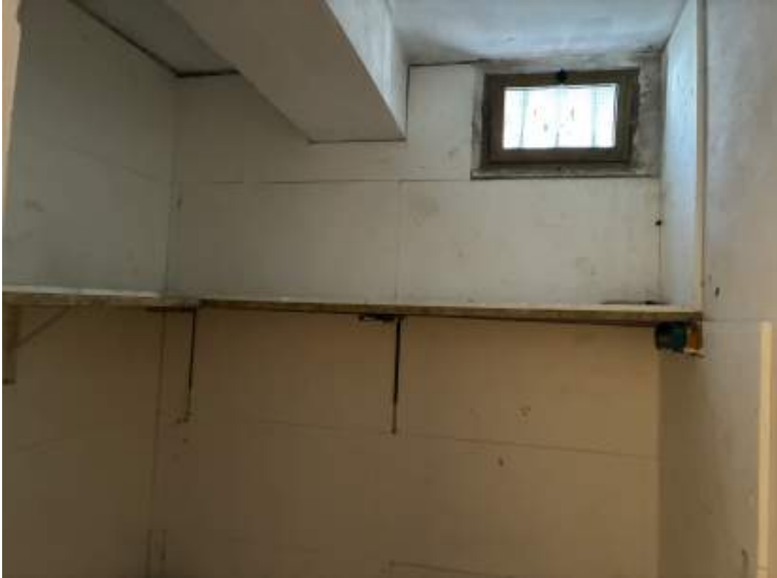
Foto 07 – Cantina al piano terra dell'appartamento sub.10 (lotto n.2).
