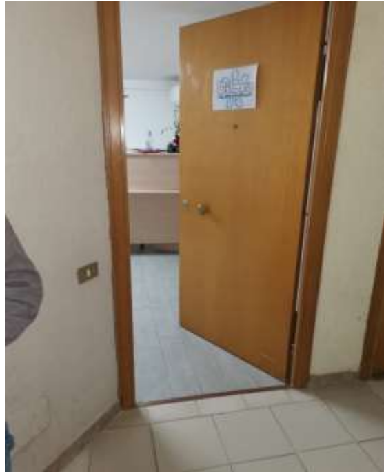
Foto n° 6 Porta di ingresso all'unità
