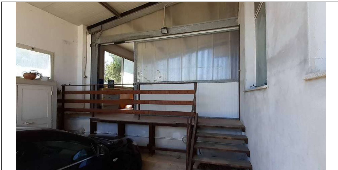
5. Ingresso al magazzino
