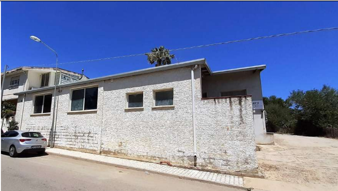
2. Vista magazzino dalla via A. Volta
