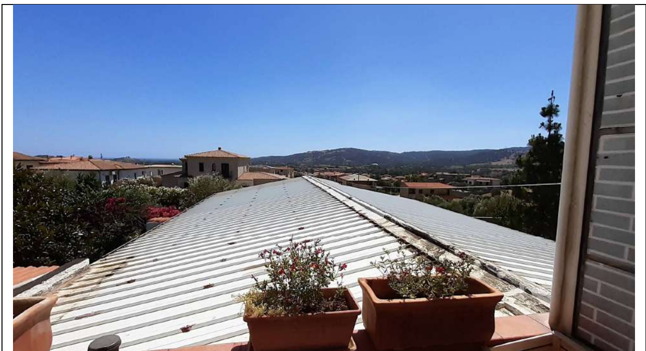
4. Vista dal sub 14_copertura magazzino e atelier in pannello sandwich
