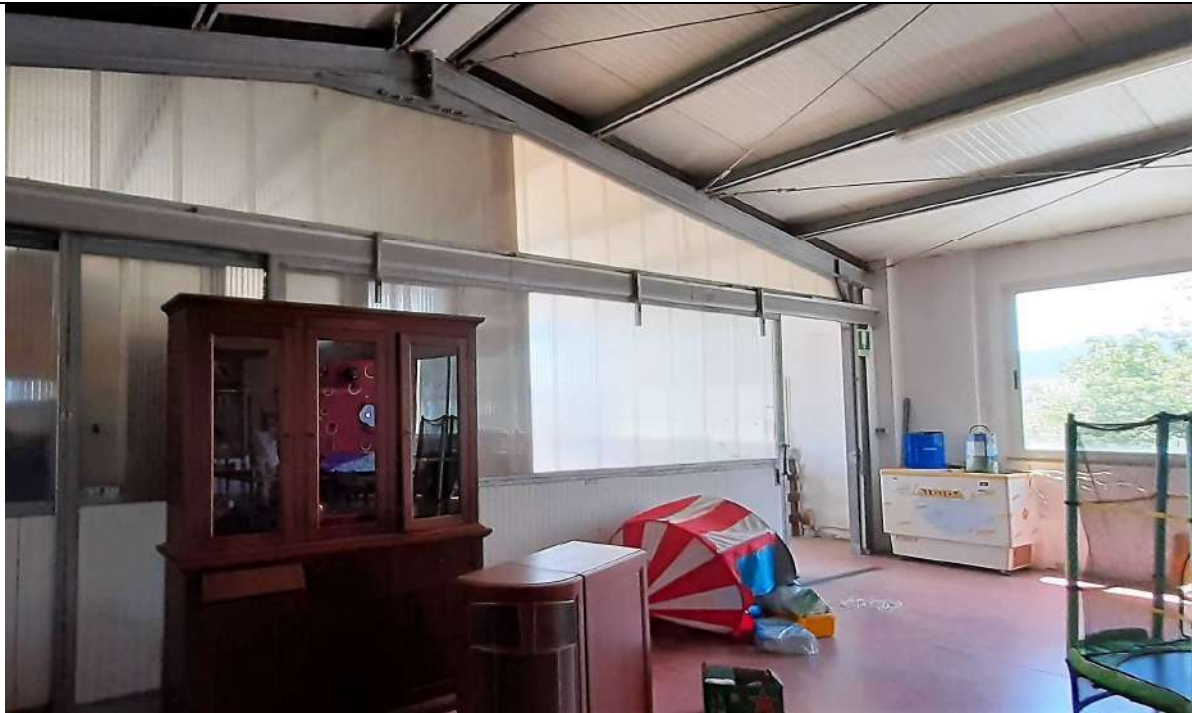
9. Vista 4 verso l'ingresso
