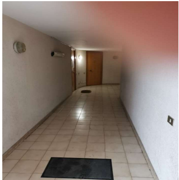
Foto n° 4 Corridoio interno al piano terra
