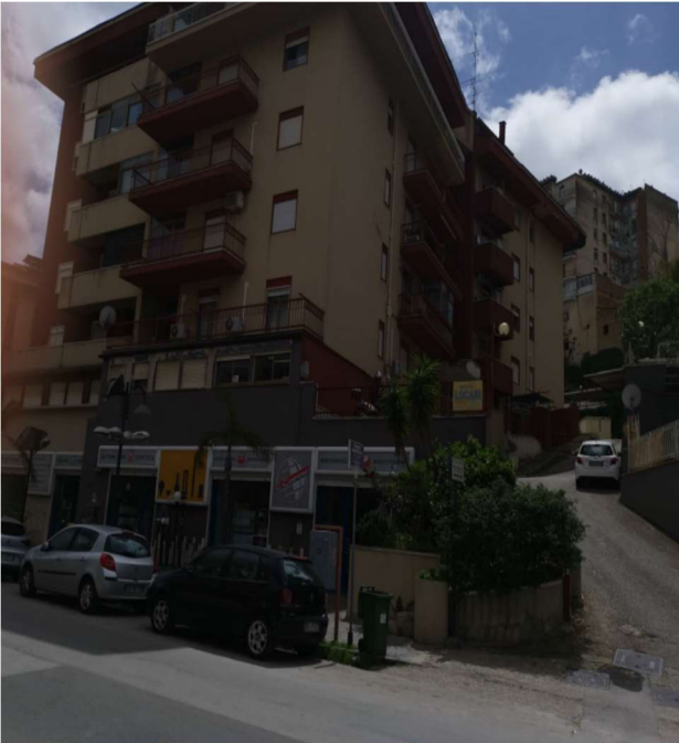
Foto n.1 Prospetto dalla via Imera
