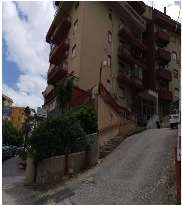
Foto n.2 Prospetto dalla traversa di via Imera
