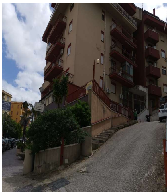
Foto n.2 Prospetto dalla traversa di via Imera
