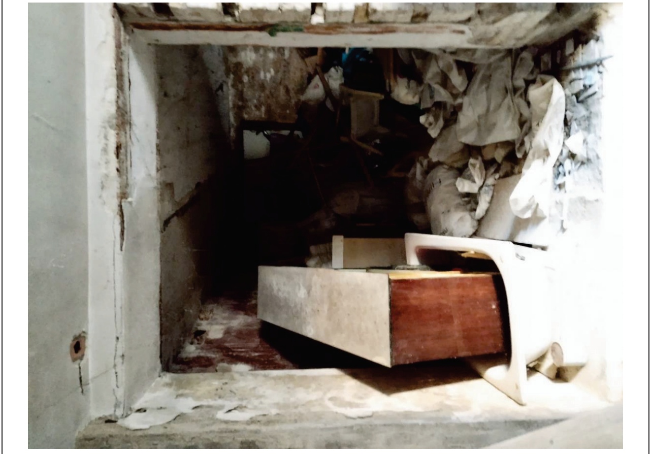
Foto n° 15 - Locali Cantina / Deposito al Piano 2° Sottostrada
