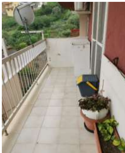
Foto n° 18 Balcone su area laterale
