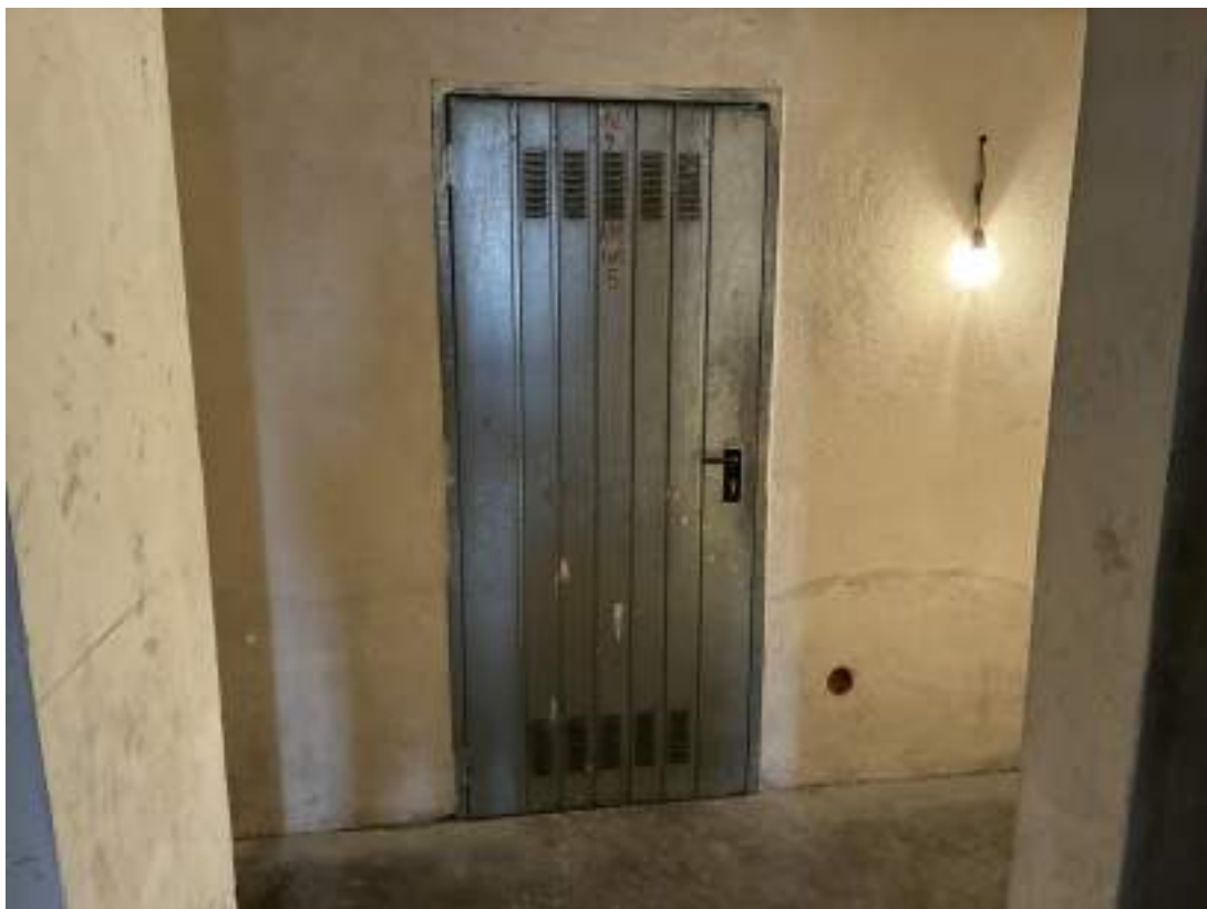
Foto 09 – Di fronte la porta della cantina dell'appartamento sub.9 (lotto n.1).
