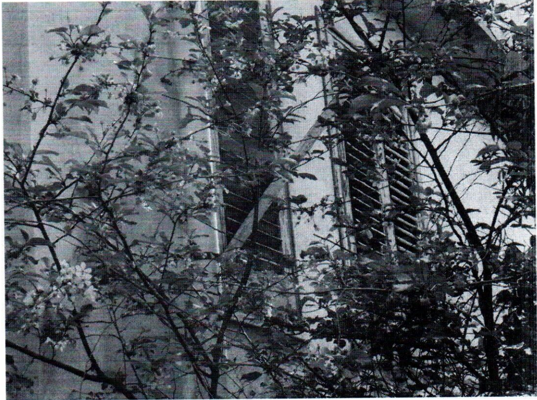
foto n. 11: vista delle finestre nel prospetto posteriore
