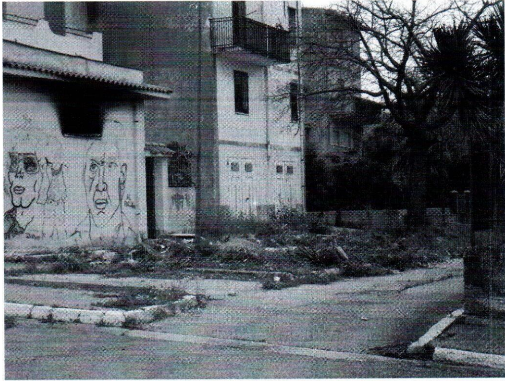
foto n. 5: ubicazione del fabbricato in Via Leopardi
