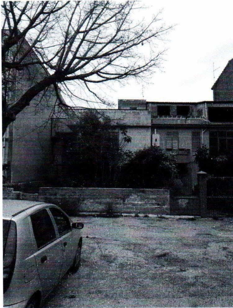
foto n. 6: prospetto di Via Leopardi
