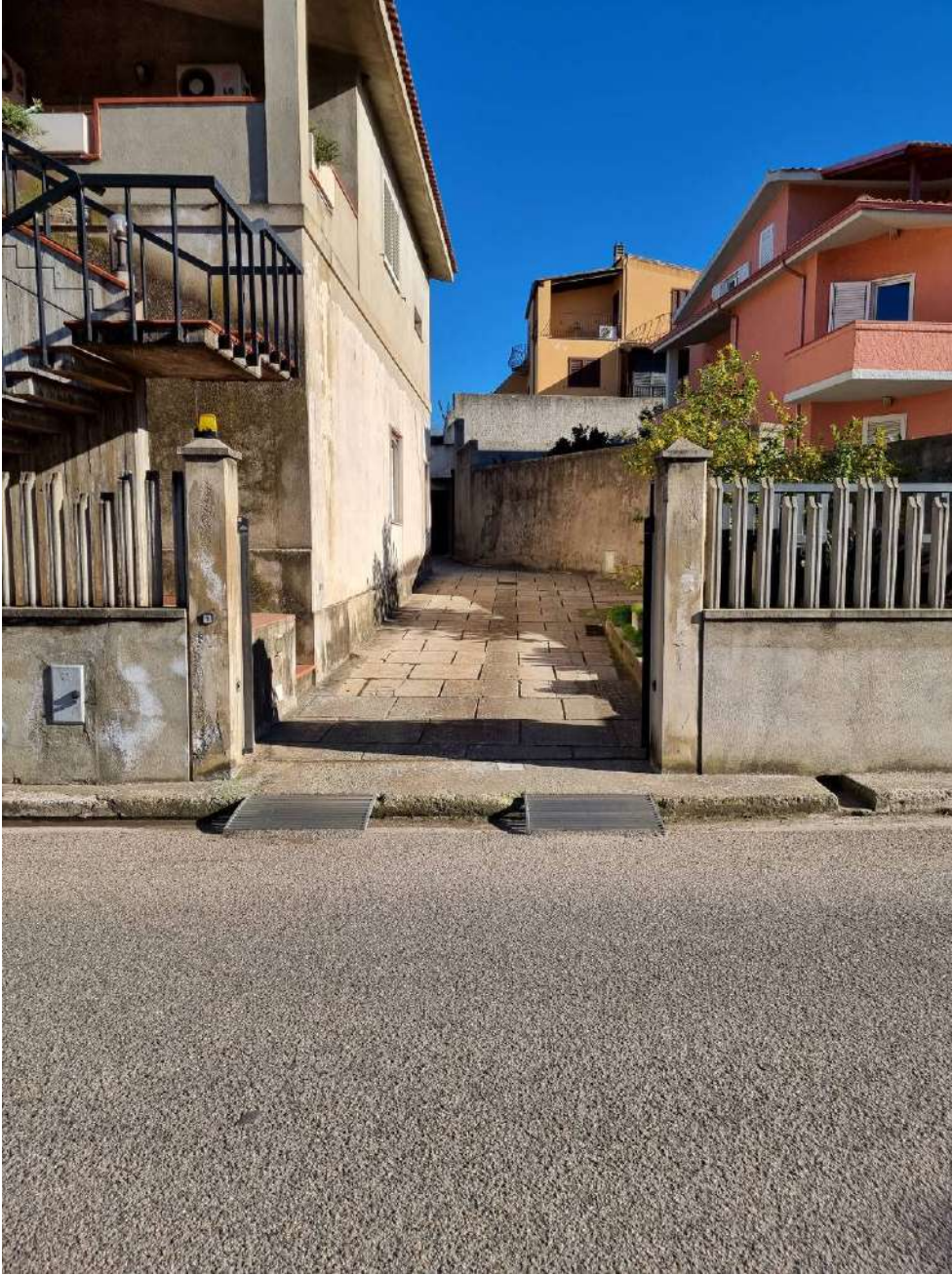
Foto 3: particolare dell'ingresso carrabile, lungo la via Cagliari in Sant'Andrea Frius.
