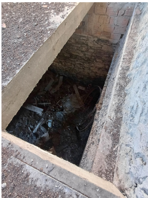
Fotografia n. 8 – interno – asola solaio col piano sottostrada
