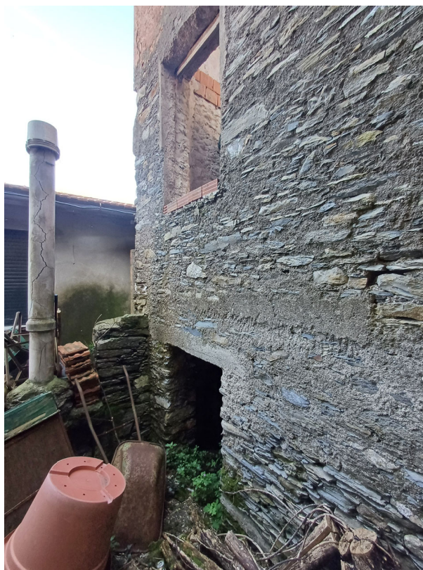
Fotografia n. 9 – accesso piano sottostrada
