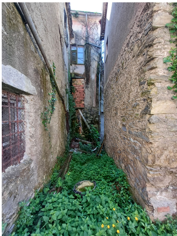
Fotografia n. 15 – vista distacco corte
