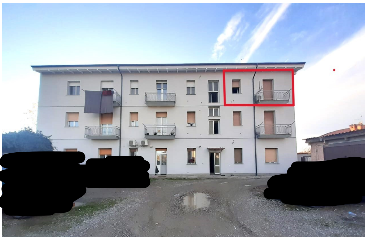
Foto Facciata Fabbricato Condominiale denominato "Palazzo del Sole"
